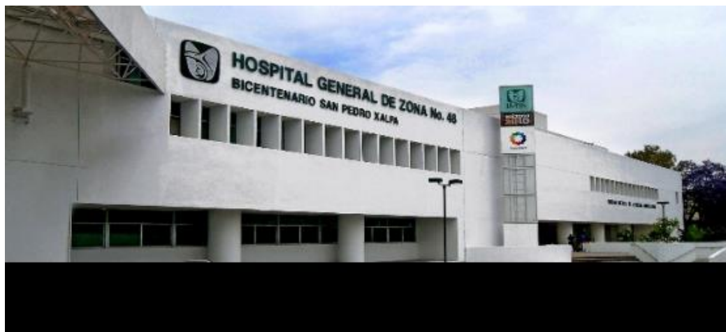
Figura 4. Hospital General de Zona 48 IMSS “Bicentenario San Pedro Xalpa”
