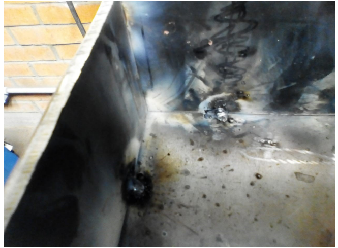
Fig. 108 Proceso de construcción de la base para la obra Kósmos (asesoría y apoyo técnico docente del escultor Margarito Leyva).
