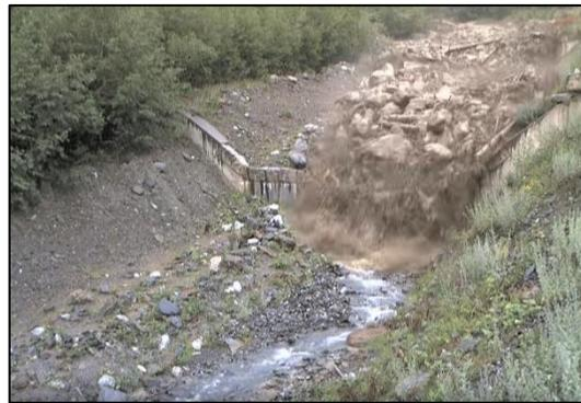
Figura 2.33. Vertedor de represa durante el debris flow.
