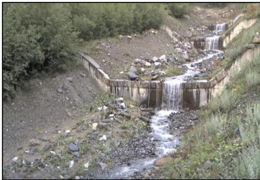
Figura 2.32. Vertedor de represa antes del debris flow.
