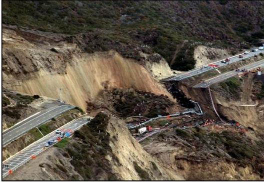
Figura 2.3. Deslizamiento de tierra en km 93 carretera Tijuana-Ensenada, Baja California, México (2013).
