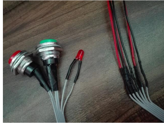
Figura 6.46 Reconexión de componentes usando thermofit en vez de usar cinta de aislar
