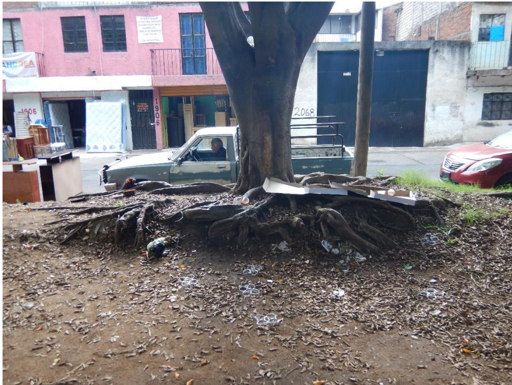
Fotografía 9. Erosión y descuido.
