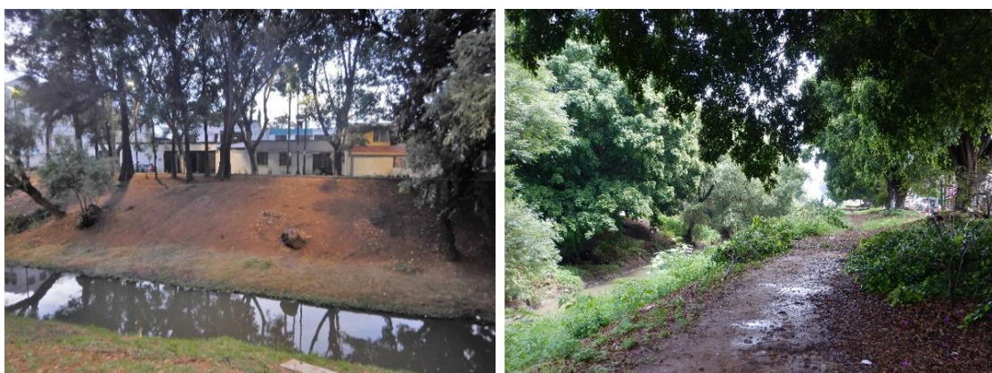
Figura 275. Fotografías comparativas sobre el cuidado y mantenimiento de riberas, la primera fotografía muestra una parte del tramo sur del río, la segunda imagen corresponde al tramo norte (Arroyo-Robles, 2018).
