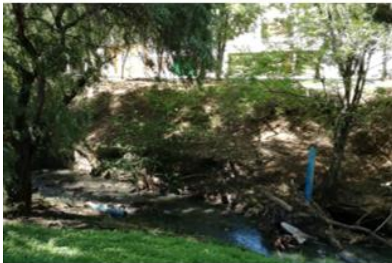
Figura 24. Serie de fotografías que muestran las condiciones en las que se encuentran el Tramo Norte (primera fotografía), con infraestructura obsoleta de un filtro mecánico que no tiene una limpieza correcta pues la basura llega a estar acumulada durante mucho tiempo; y Tramo Sur señalando la guarnición discontinua, la coladera como un peligro para los peatones (segunda fotografía), y los desagües en desuso (tercera fotografía) (Arroyo-Robles, 2018).
