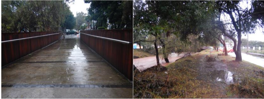
Figura 25. Inicio del Parque Lineal en la Avenida Sansón Flores en la que se observan los encharcamientos presentes en temporada de lluvias. En la segunda fotografía se muestra una zona del Tramo Sur que durante la temporada de lluvias es de difícil acceso (Arroyo-Robles, 2018).
