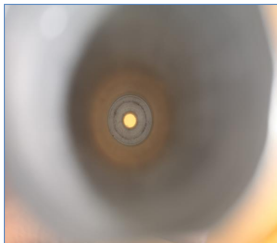
Imagen 16. Interior y profundidad del tubo (Autoría propia).
