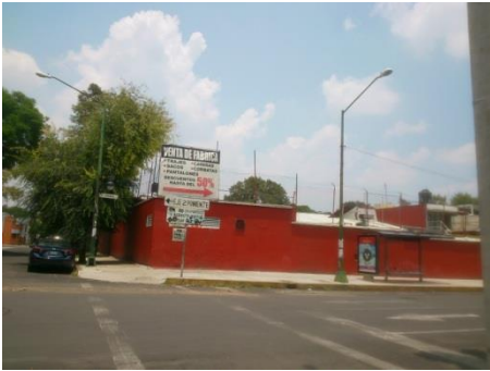
Figura 9 y 10, Frente al predio sobre calle París. Elaboración propia.
