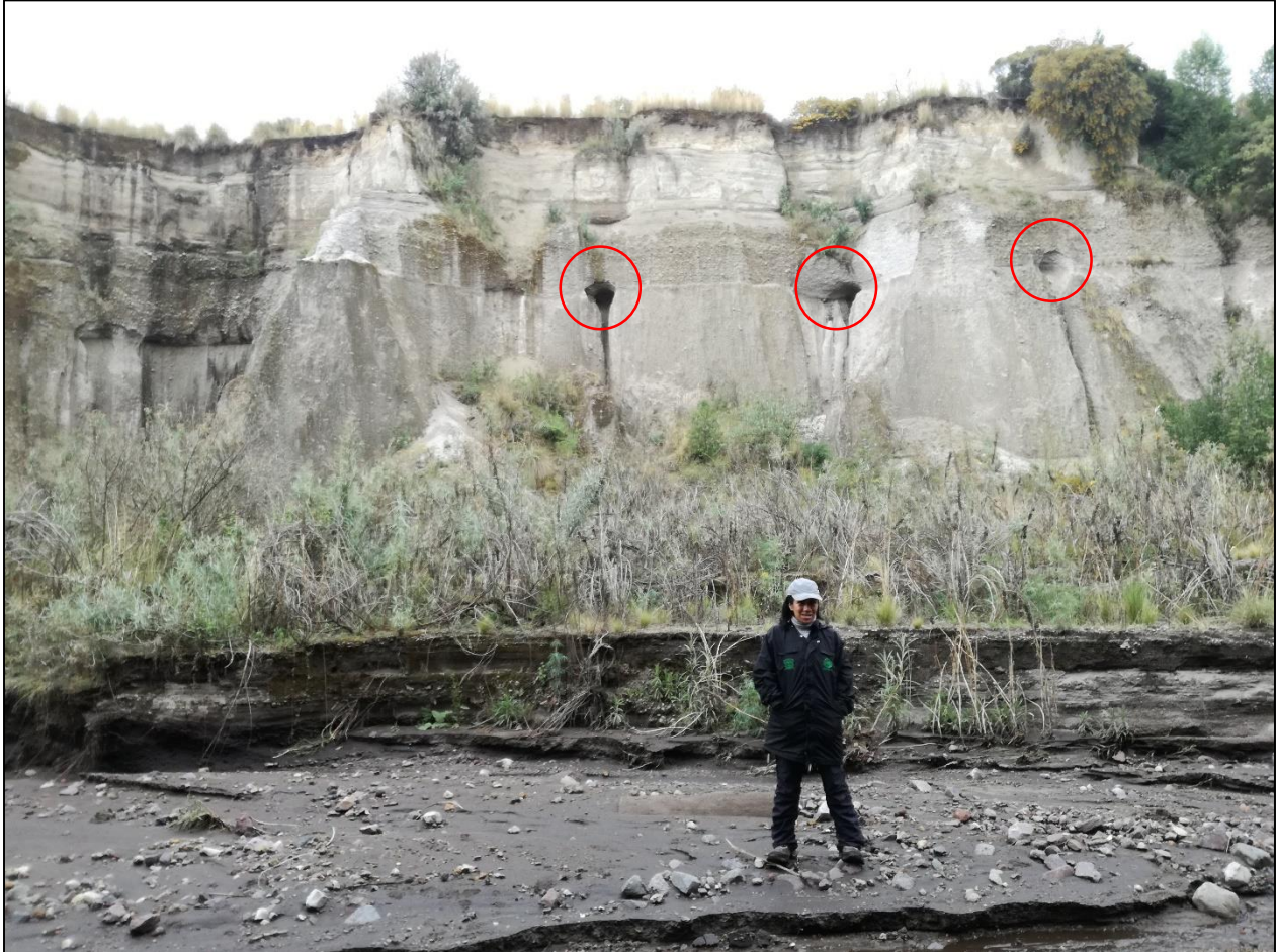
Figura 8.2. Socavación interna en depósitos piroclásticos (círculos rojos) producto de la acción erosiva de flujos de agua subsuperficiales en las paredes de la barranca El Zaguán (cuenca media).
