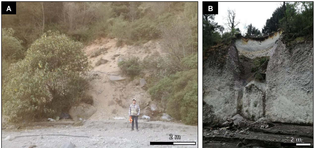
Figura 6.24. Deslizamientos rotacionales en la barranca.
