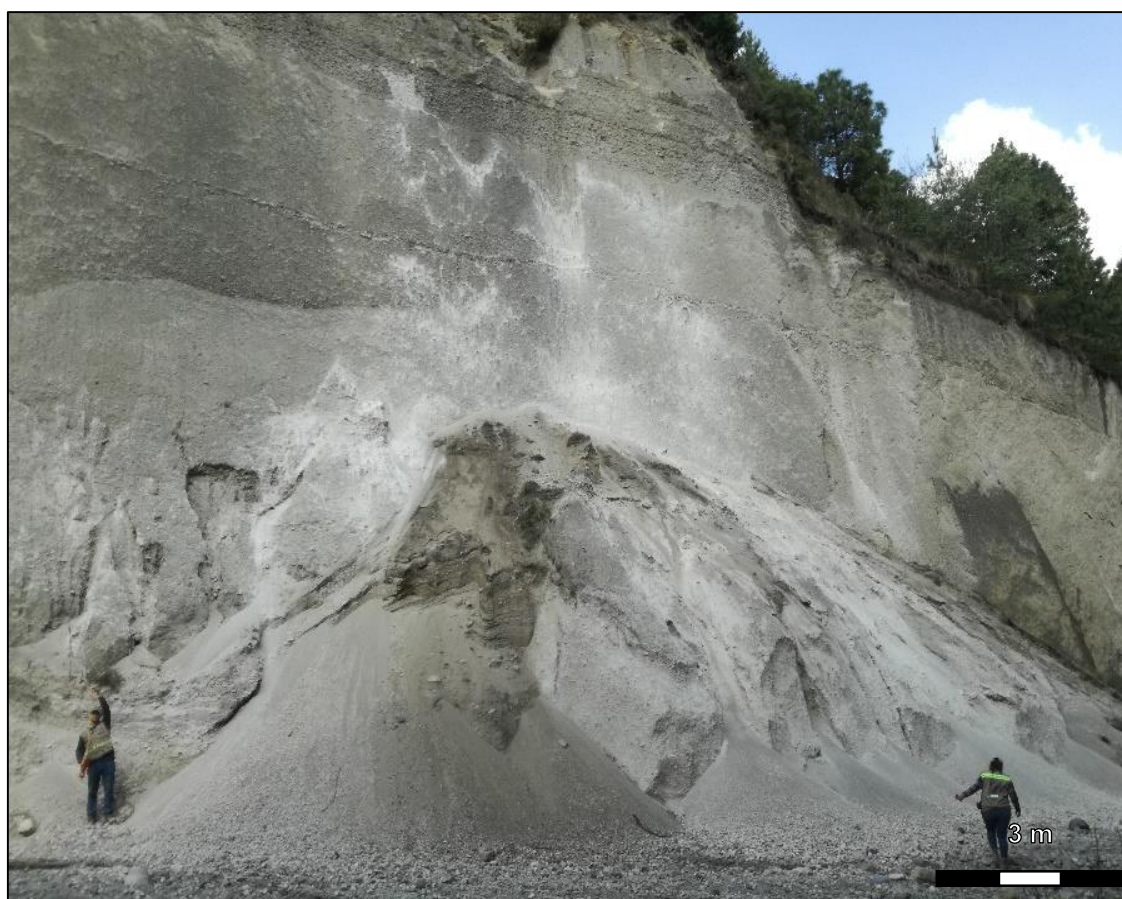
Figura 6.21. Proceso de remoción en masa de tipo caída dentro de la barranca El Zaguán.
