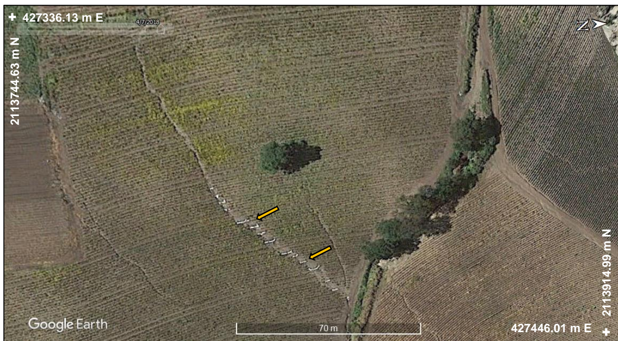
Figura 6.5. Ensanchamiento de los surcos erosivos en la cuenca media, con obras de contención. Imagen satelital del año 2017 (Google, 2018). Las flechas amarillas señalan el surco ensanchado y las obras de contención (barras blancas).
