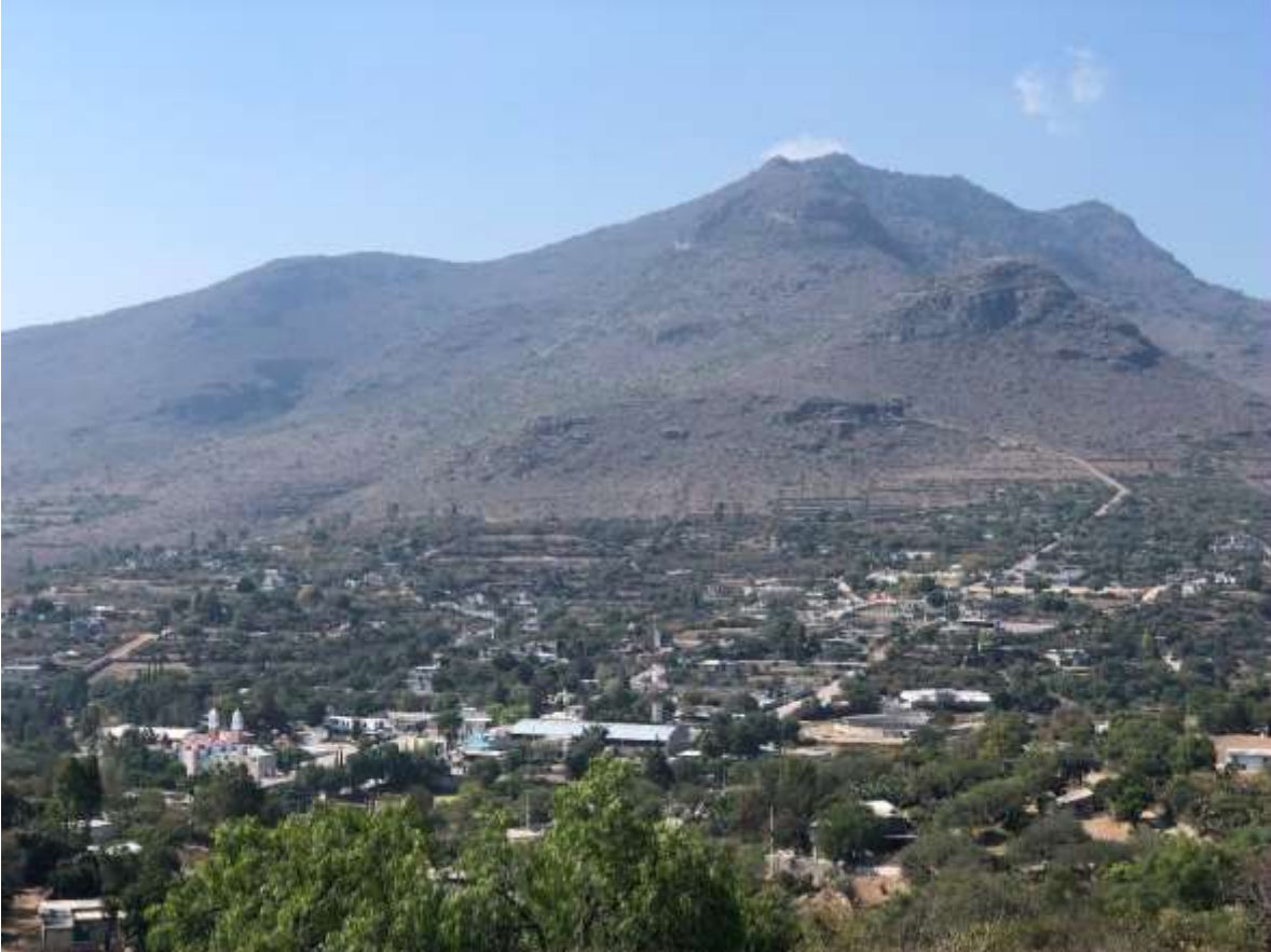
Anexo 12 Centro de Tepeitic. Vista del centro de Tepeitic desde la “Capilla de la Cumbre” (desde el este al oeste). Es notoria la trama urbana irregular sobre una topografía accidentada. Fotografía propia (2019).
