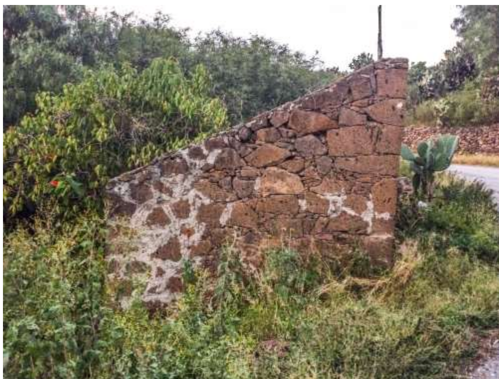
Anexo 3 Viviendas tipo. Ambas imágenes muestran la materialidad inaugural de las viviendas típicas en Tepeitic desde su fundación. Se trata de materiales vernáculos del sitio (muros de cantera, pisos pétreos de laja y techos a base de viguería de mezquite y tejado de barro); ambas forman de los últimos ejemplares en su tipo y se encuentran en abandono. Fotografías propias (2018).
