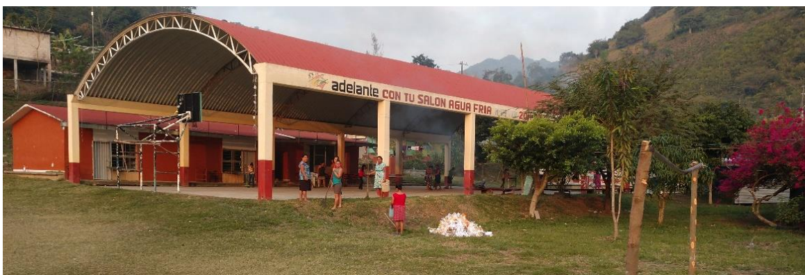
Ilustración 6. Escuela y galería de la localidad. En el plano intermedio, mujeres en faena de limpieza.
