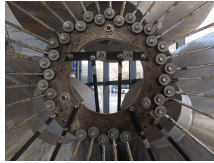
(b) Detalle de una escultura donde se aprecian las barras encastradas.
