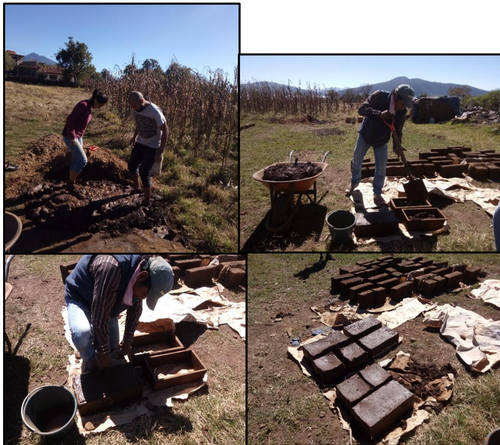
Figura 20. Elaboración de bloques de adobe
