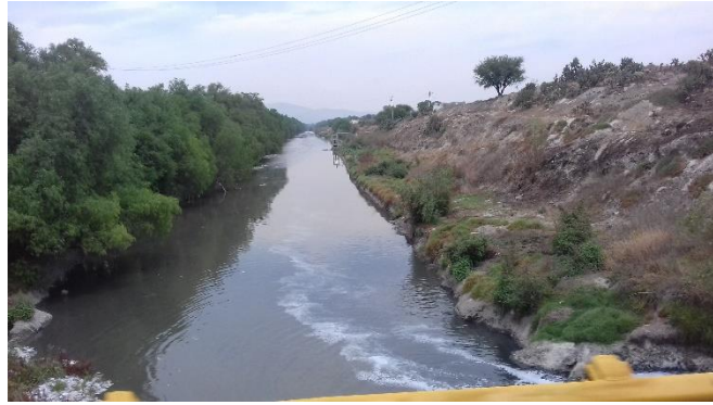
Fotografía propia del canal de desagüe
