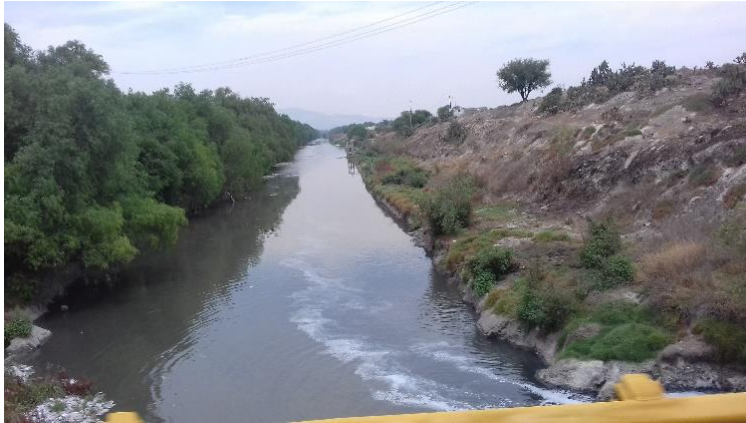
Fotografía del canal de desagüe de la Ciudad de México que divide el municipio de Nextlalpan, Fotografía propia
