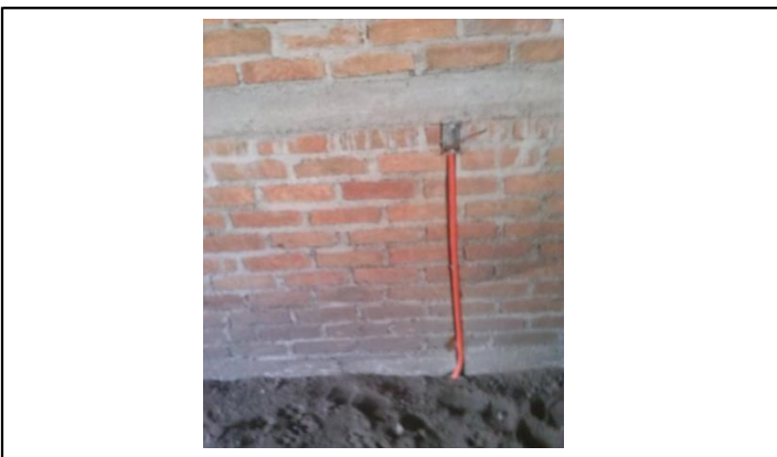
TENDIDO DE POLIDUCTO
