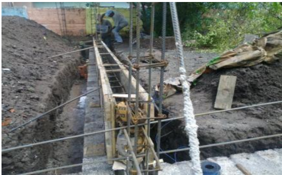
MURO DE ENRASE DE 21 CM
