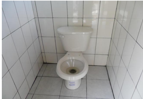
COLOCACION DE W.C
