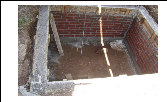
MURO DE TABIQUE ROJO
