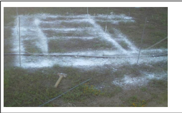
LIMPIA, TRAZO Y NIVELACION
