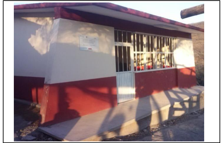
PINTURA DE HERRERIA
