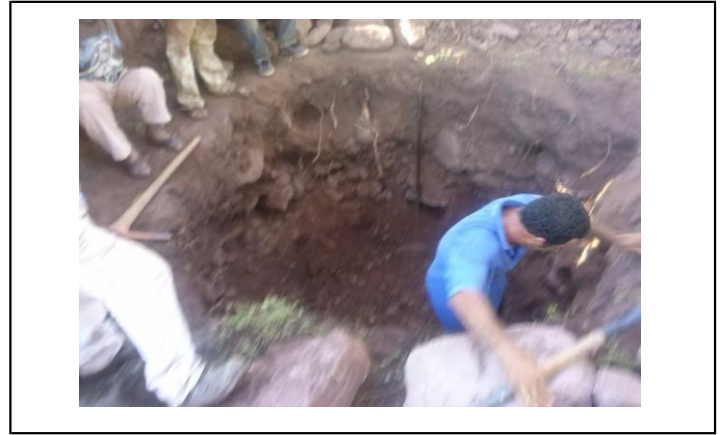
EXCAVACION A MANO
