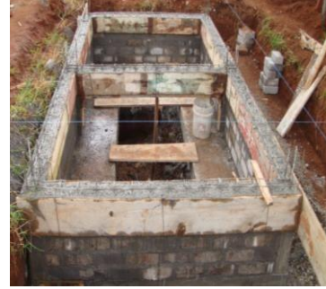
APLANADO DE MUROS
