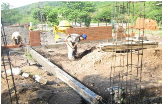
RELLENO CON MATERIAL DE BANCO
