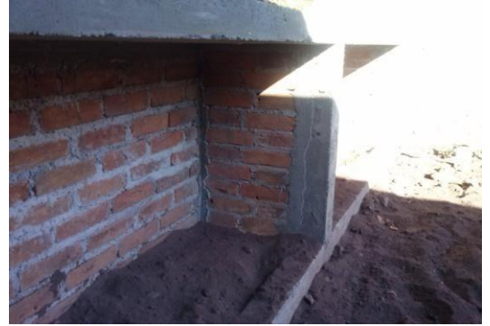
RELLENO DE MATERIAL EXCAVACIÓN
