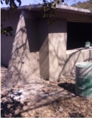
ALB012.- Aplanado muros
