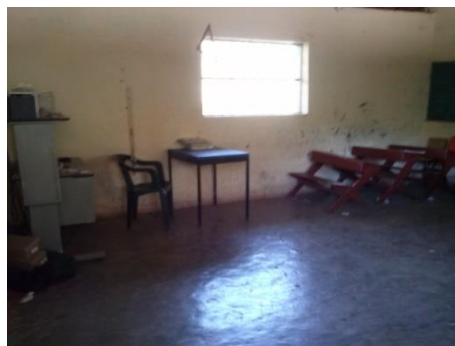
Vista de aula en uso interior imagen (b-2)
