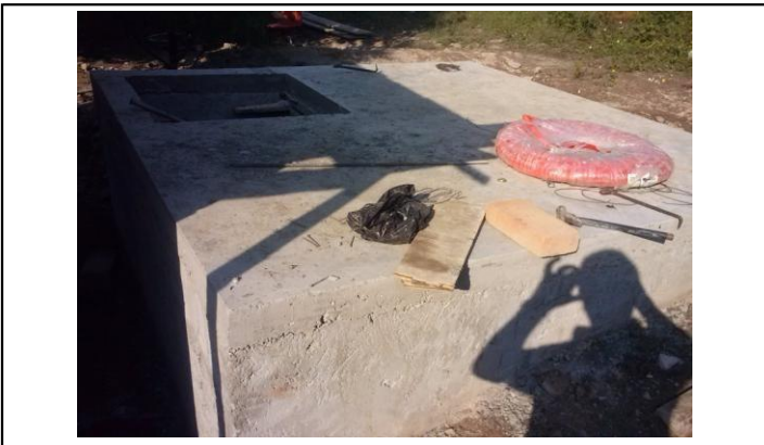
RELLENO CON MATERIAL PRODUCTO DE EXCAVACIÓN
