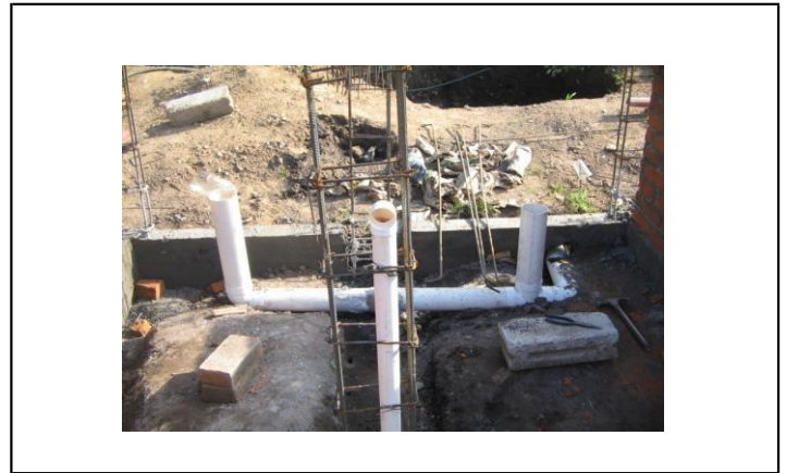
EXCAVACION A MANO
