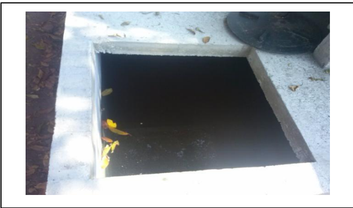
LOSA DE CONCRETO
