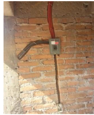
tendido de tuberia
