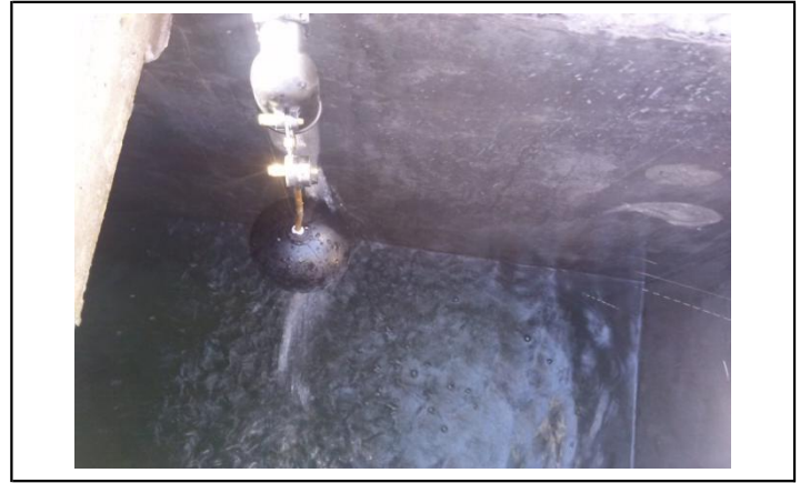
INTERRUPTOR DE FLOTADOR
