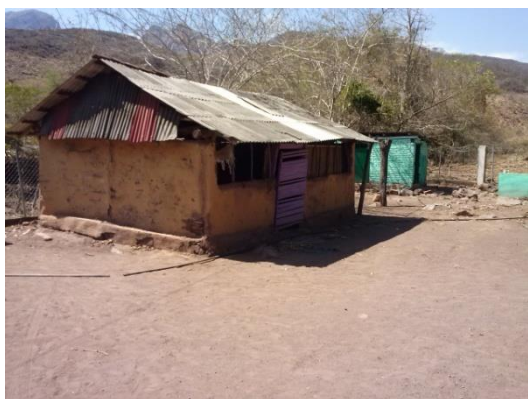
Vista de cuarto del maestro imagen (b-3)
