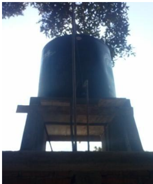
COLOCACION DE TINACO MARCA ROTOPLAS
