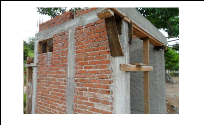
MURO DE TABIQUE ROJO
