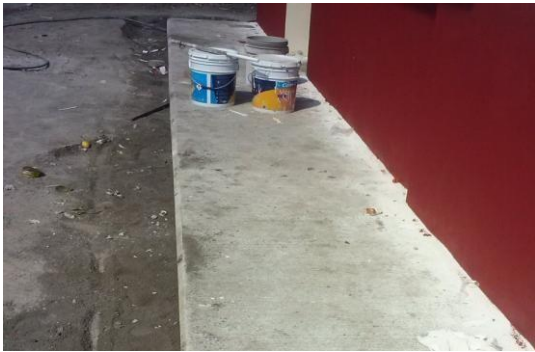
ALB005.- Banqueta de concreto
