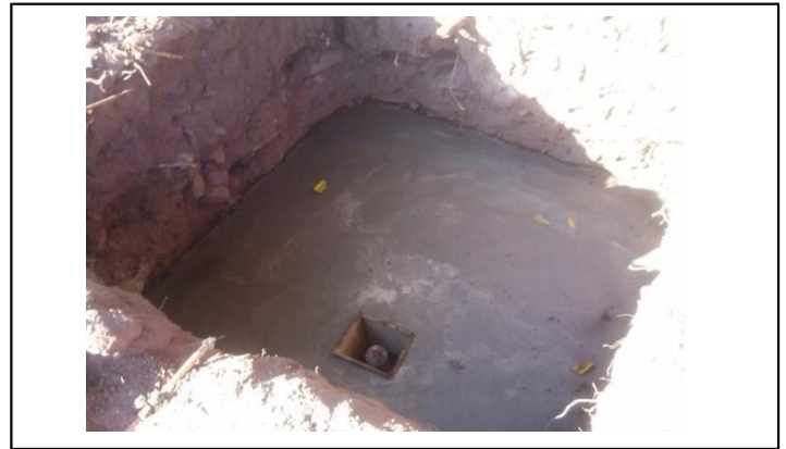
LOSA DE FONDO, DE CONCRETO ARMADO
