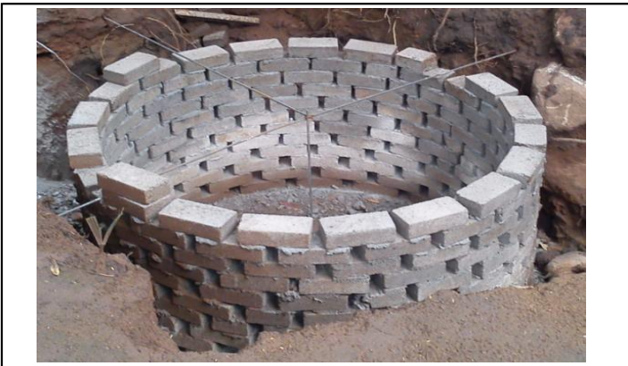
MURO DE TABICON
