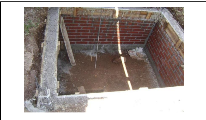
MURO DE TABIQUE
