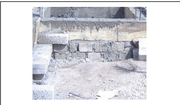
MURO DE TABICON
