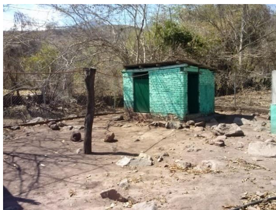
Baño de pozo imagen (b-4).
