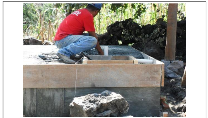
LOSA SUPERIOR DE CONCRETO
