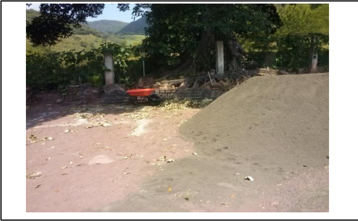
LIMPIEZA, TRAZO Y NIVELACION
