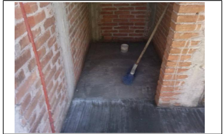
FIRME DE CONCRETO
