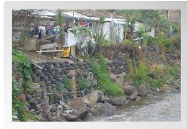
Ilustración 15 vivienda informal en la ribera del Río Pasto
