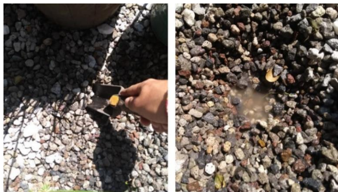
Figura 28. Preparación de sitio para colocación de la vegetación.
