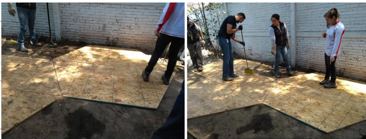
Figura 17. Acomodo de bases de módulos del HAM.
