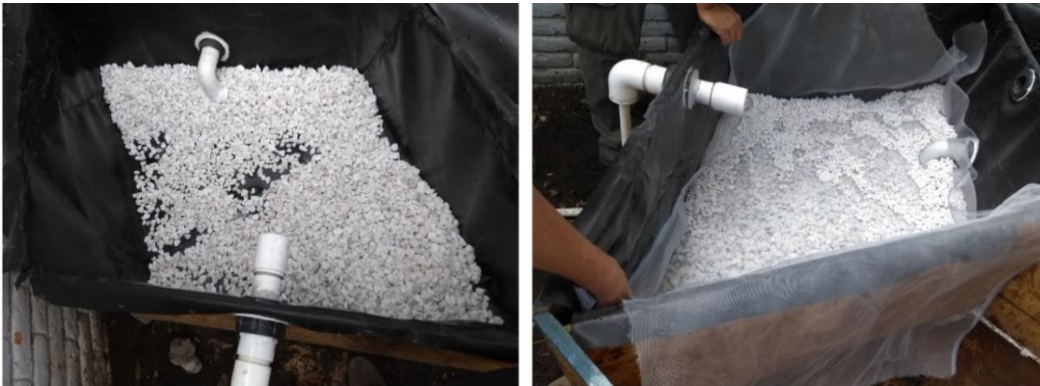
Figura 27. Colocación de maya en el módulo 1.
