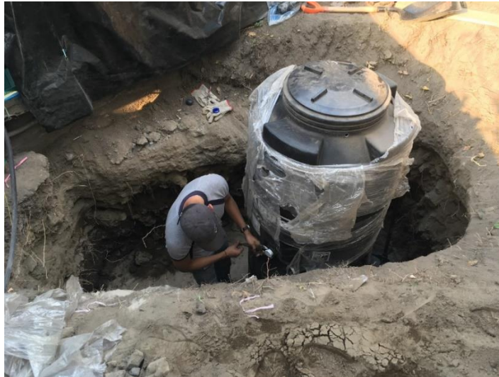
Figura 15. Colocación de Tanques.
