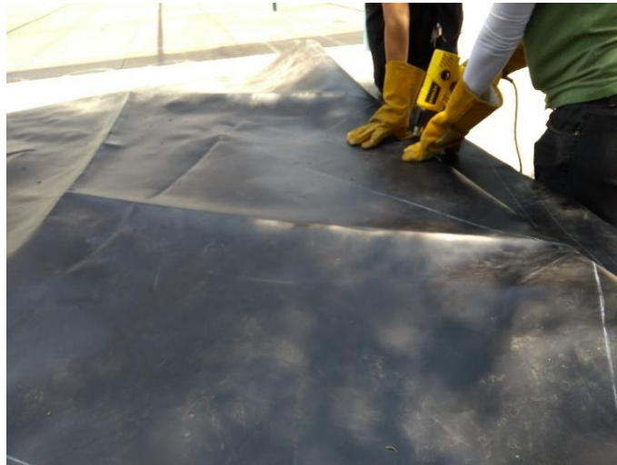
Figura 20. Doblado de geomembrana.
