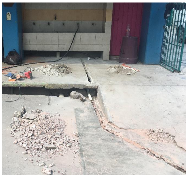
Figura 23. Obra para conexión de tubería.
