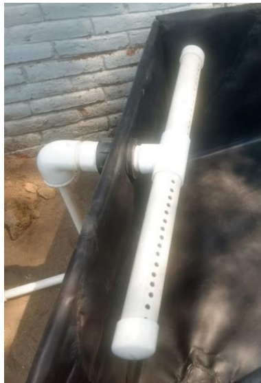
Figura 26. Montado completo de tubería de distribución de agua a tratar.
