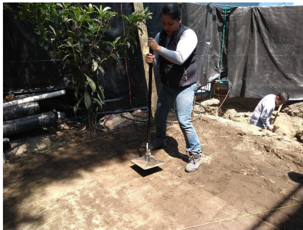
Figura 16. Aplanado del área de instalación.
