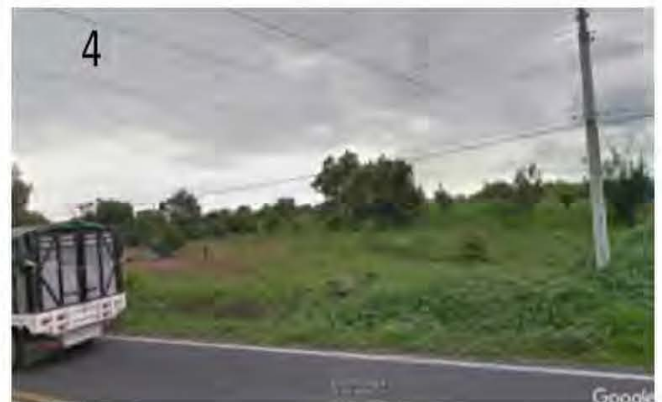
4.- Intersección de la línea de alta tensión y la autopista Tepetlixpa-Atlatlahuaca, entre la cabecera municipal y San Miguel Nepantla.
