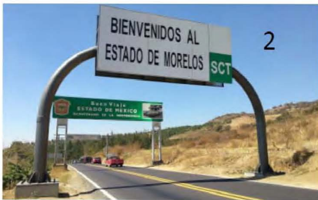
2.- Carretera Atlatlahuaca-Tepetlixpa, específicamente en el límite carretero de Tepetlixpa y Morelos, el cual se localiza en el Primer Arco que divide a los estados.
