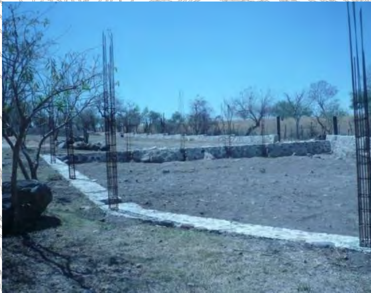
Núcleo de servicios en proceso de construcción.
