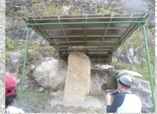
Fig 2.- Pieza protegida con sistema de postes metálicos y placa de policarbonato con filtro solar.
