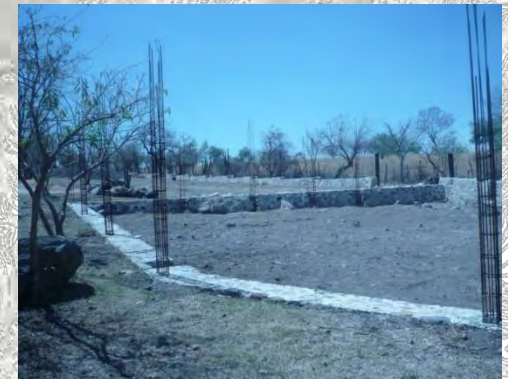
Núcleo de servicios en proceso de construcción.
