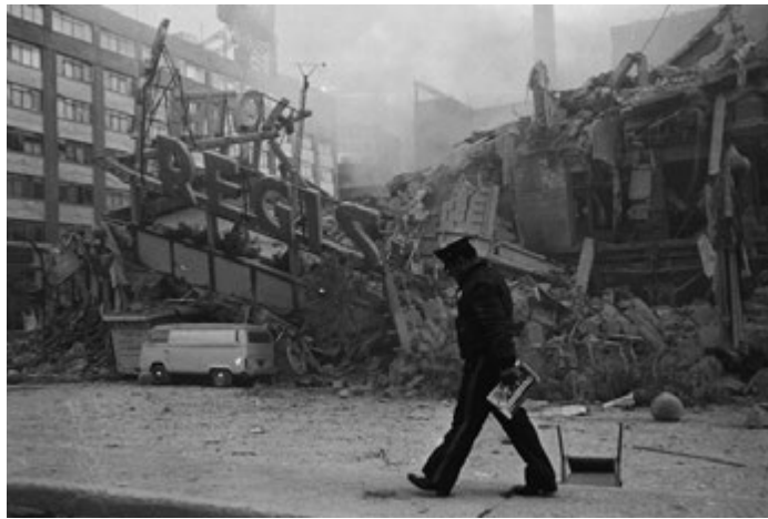
FOTOGRAFÍAS 15 Y 16 Estragos que causó el sismo de 1985 en el centro de la Ciudad de México.
