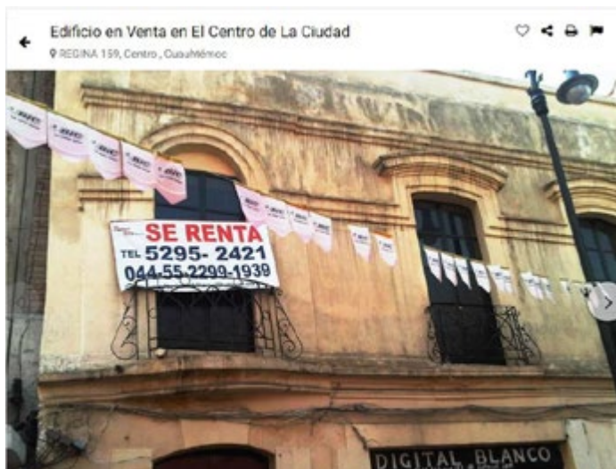
FOTOGRAFÍA 52 Edificio en venta o renta en el Centro Histórico.
