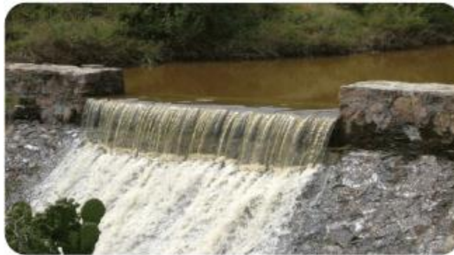
Figura 2-2 Vertedor de caída recta y descarga directa
