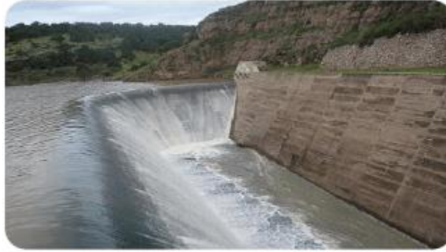
Figura 2-3 Vertedor de cimacio con canal lateral
