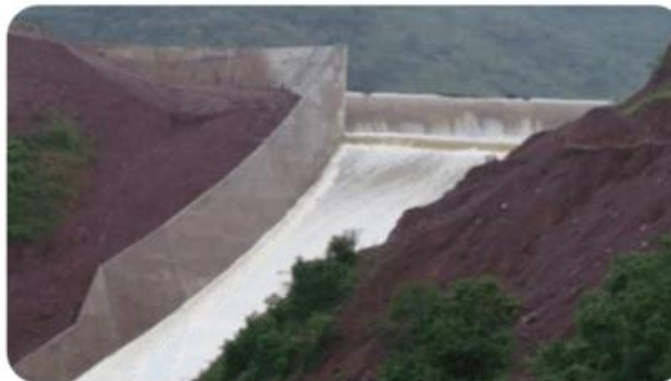
Figura 2-1 Canal de descarga recto
