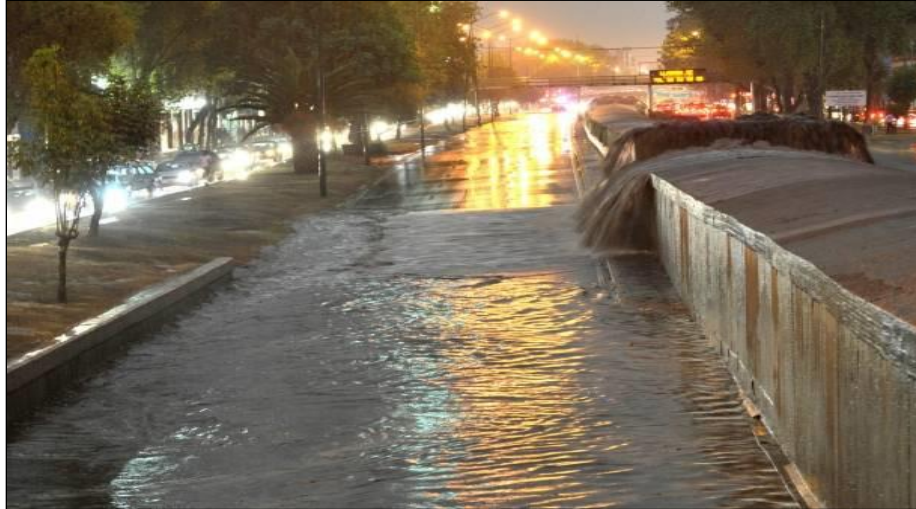
Figura 1.5 Colapso del río de la Piedad en 2011.
