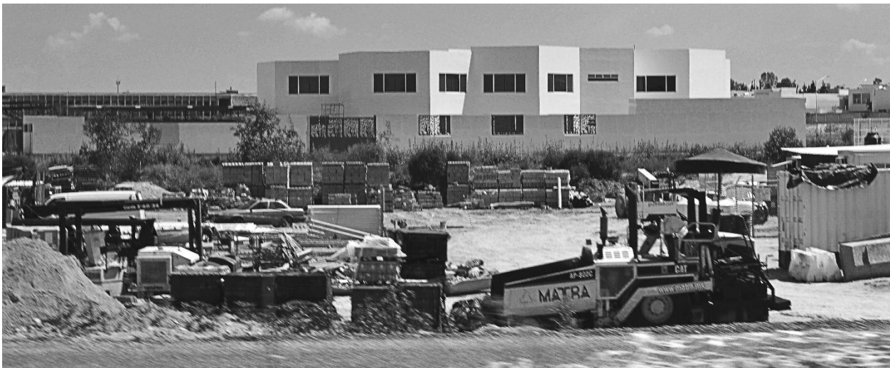
Ilustración 16. Construcción de un conjunto de viviendas en serie en la Ciudad de Aguascalientes
