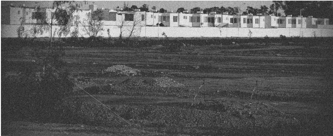
Ilustración 69. Vista al exterior común de un conjunto de viviendas en serie
