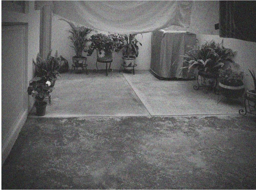
Ilustración 77. Adecuación del patio de servicio.
