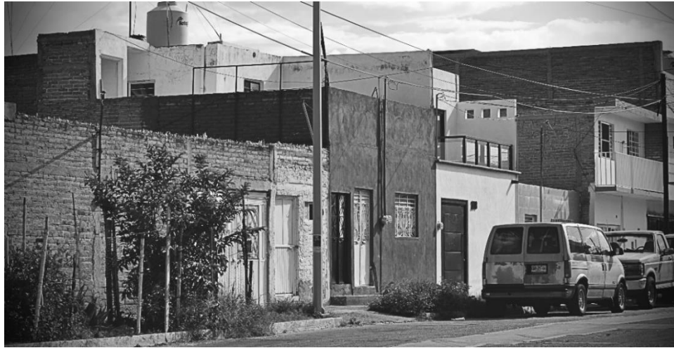
Ilustración 12. Viviendas en la colonia “Las Flores”
