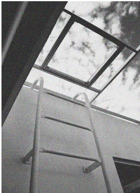
Ilustración 78. Adecuación del cubo de luz: protección y mosquitero.
