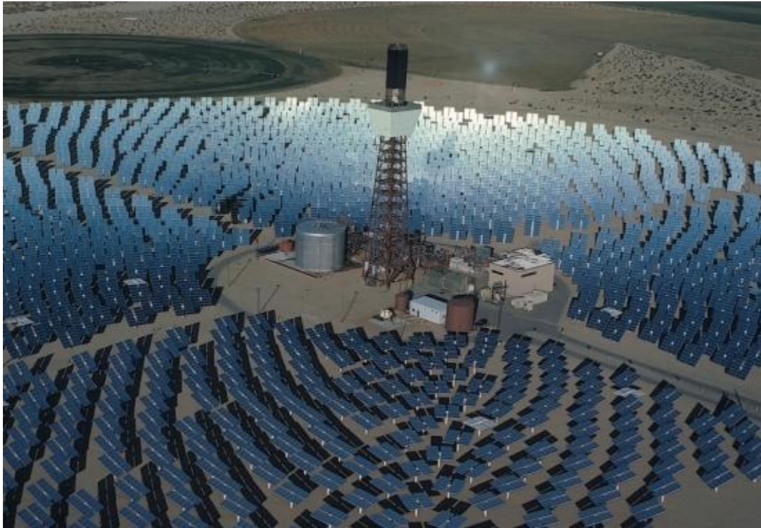
Figura 10. Central térmica solar de torre central. Fuente: Extraído de [14].
