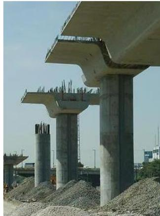
**Figura 8.1.** Columna de un puente con su tablero.
