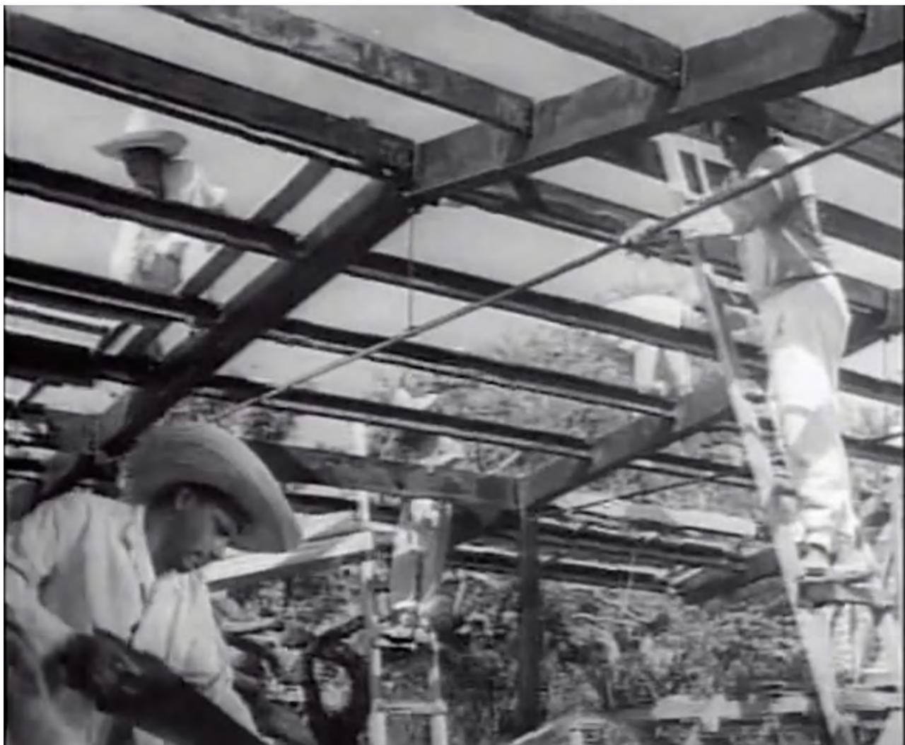
Imagen 22. Escena de la construcción de la escuela. Nótese que se trata de una estructura prefabricada.
