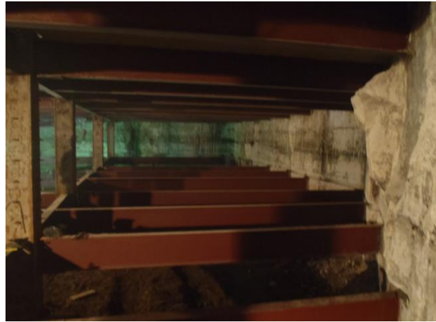
Figura 44. Montaje de las traves metálicas (primarias y secundarias) en el nivel -5.4 m. Fuente: Cortesía del proyecto Marina 385
