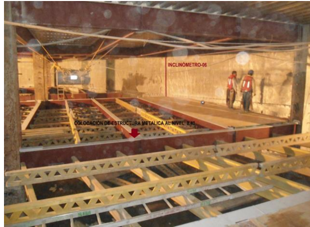
Figura 46. Colocación de traves metálicas y cimbra en el nivel -8.4 m. Fuente: Cortesía del proyecto Marina 385
