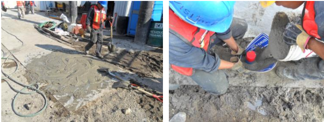
Figura 60. Elaboración de lechada en obra y colocación de lechada en espacio anular. Fuente: Cortesía del proyecto Marina 385
