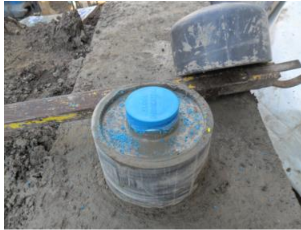
Figura 61. Inclinómetro vertical instalado. Fuente: Cortesía del proyecto Marina 385
