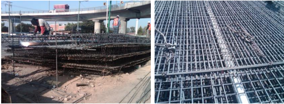
Figura 55. Colocación de tubería de PVC de 6" en armado de parrilla. Fuente: Cortesía del proyecto Marina 385
