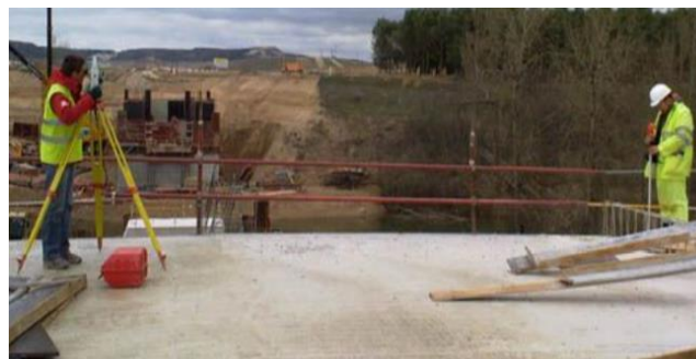
Figura 68. Medición de referencias superficiales. Fuente: http://axisima.com/en-que-consiste-la-nivelacion-topografica/
