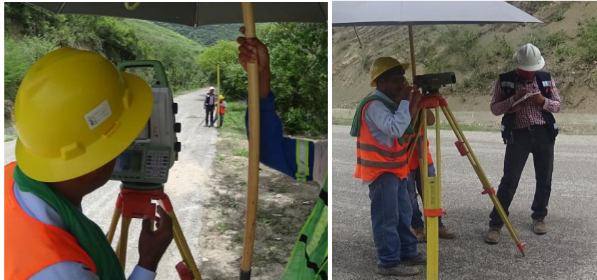
Figura 67. Equipo topográfico y accesorios usados para medición de las referencias topográficas. Fuente: Proyecto Hidroeléctrico Chicoasén II, año 2016
