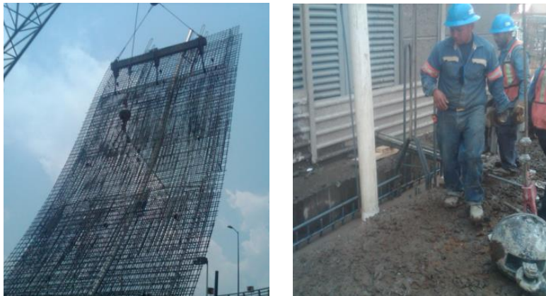
Figura 56. Izaje del armado del muro y colocación dentro de la excavación. Fuente: Cortesía del proyecto Marina 385
