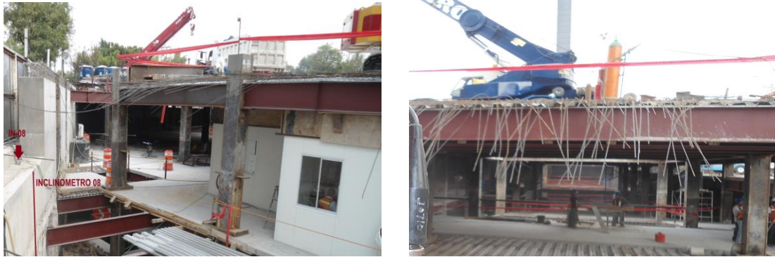
Figura 38. Construcción del sistema de pisos en nivel +1.8 m. Fuente: Cortesía del proyecto Marina 385
