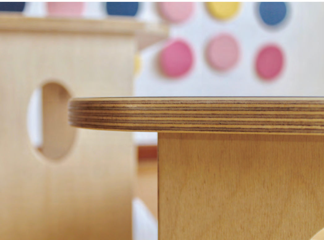
Fig.16.82: Detalle de canto de módulo de interacción
