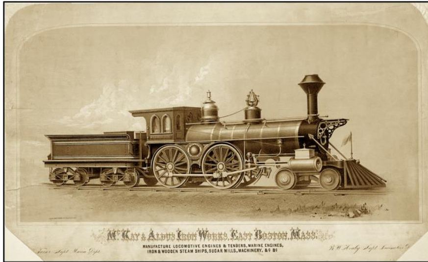
Ilustración 3 Introducción de la locomotora (aion.mx)
