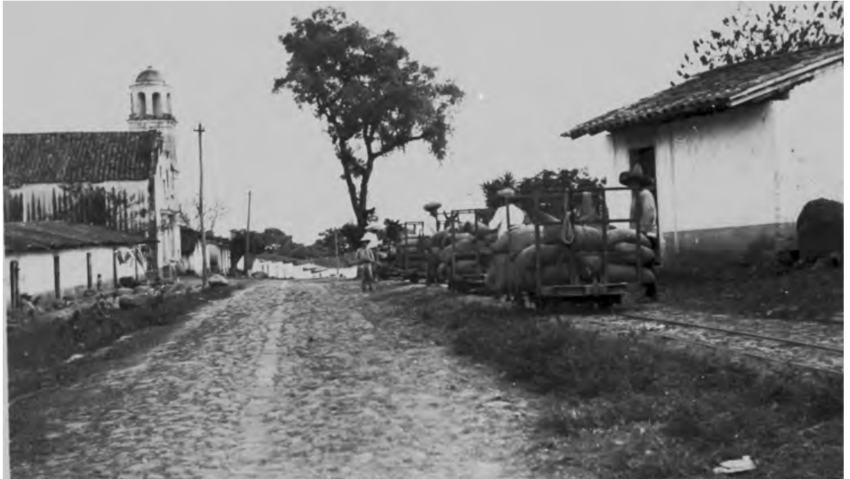
Calzada en Zimpizahua con góndolas y vía transportando el café hacia el ferrocarril. 1905. Archivo General del Estado, fondo Coatepec, No. de inventario 106, rollo 10, tira 1, negativo 1,2. En esta imagen se aprecia el ramal construido por la hacienda para transportar su producción hasta el entronque con el Piojito.
