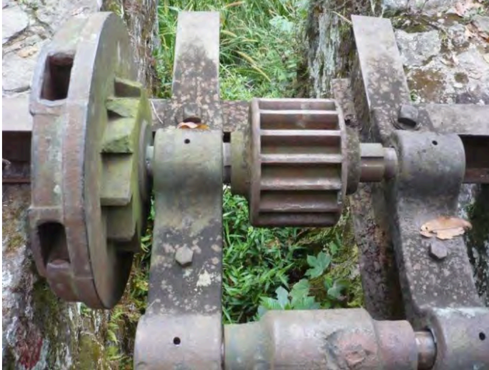
Restos de la turbina de la hidroeléctrica de Texolo. Fuente de Internet.
