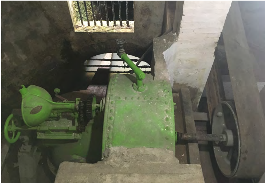
Turbina hidráulica y bandas que accionan los secadores mecánicos. Beneficio de La Mata. Coatepec. RHF, 2017.
