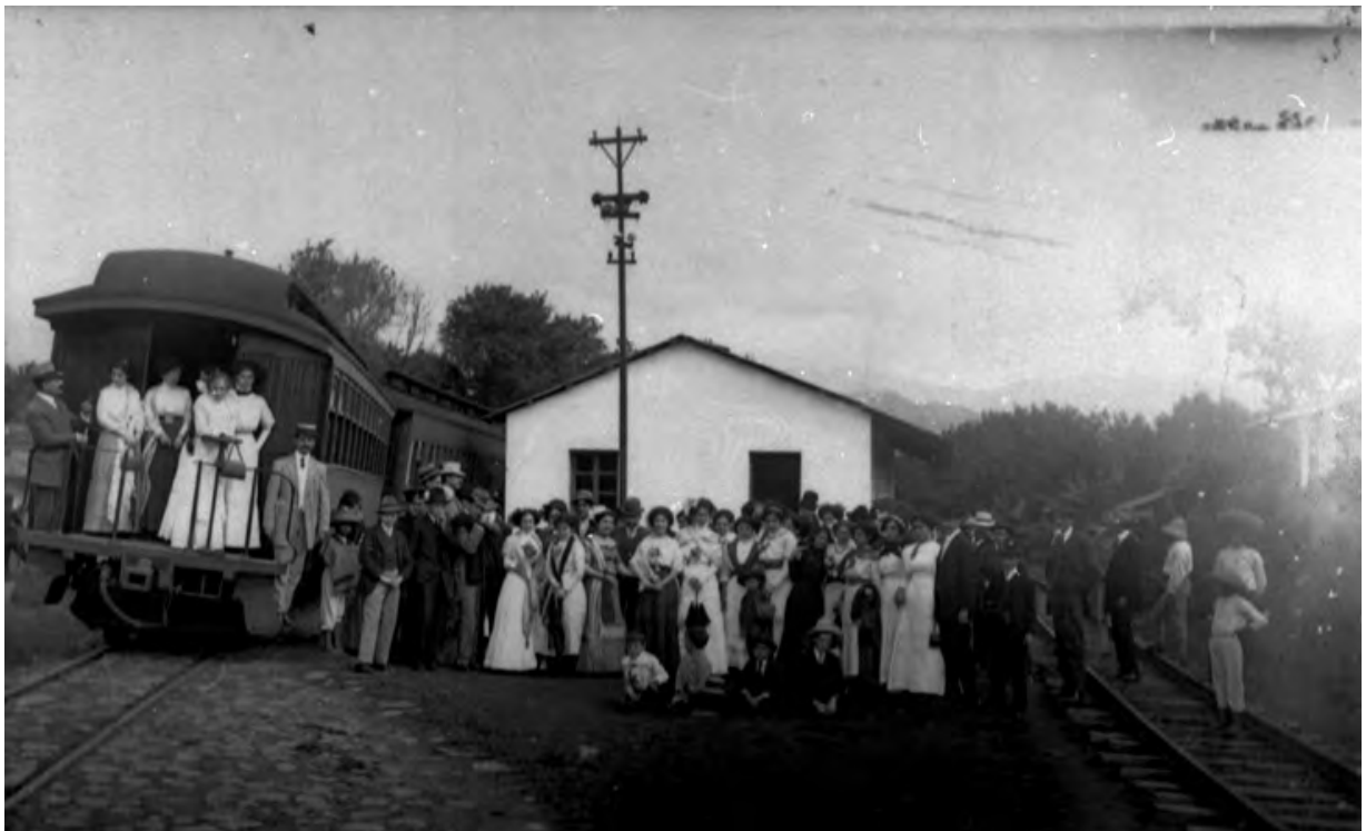
Estación del Pijito en Teocelo y poste con instalación eléctrica. 1911. Archivo General del Estado, fondo Xalapa, No. de inventario 317, rollo 41, tira 1, negativo 3.
