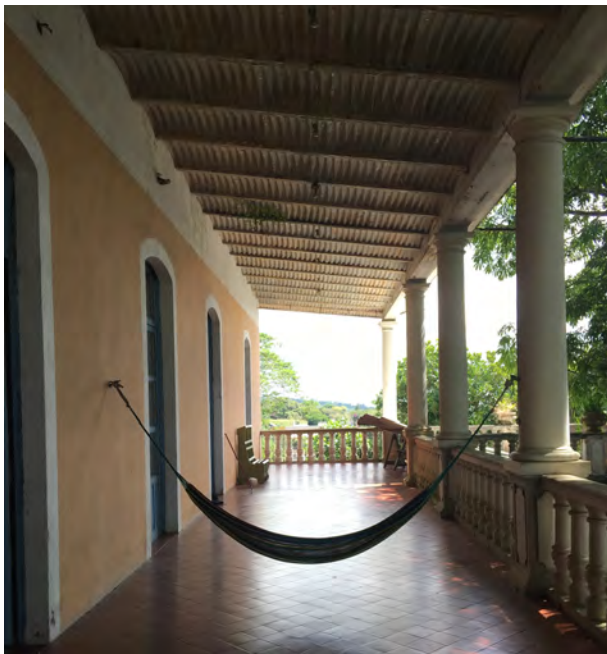
Corredor porticado en el segundo nivel de la casa grande de la Orduña. Aquí se aprecia el sistema de cubierta con vigueta y bovedilla de lámina de zinc. RHF, 2018.
