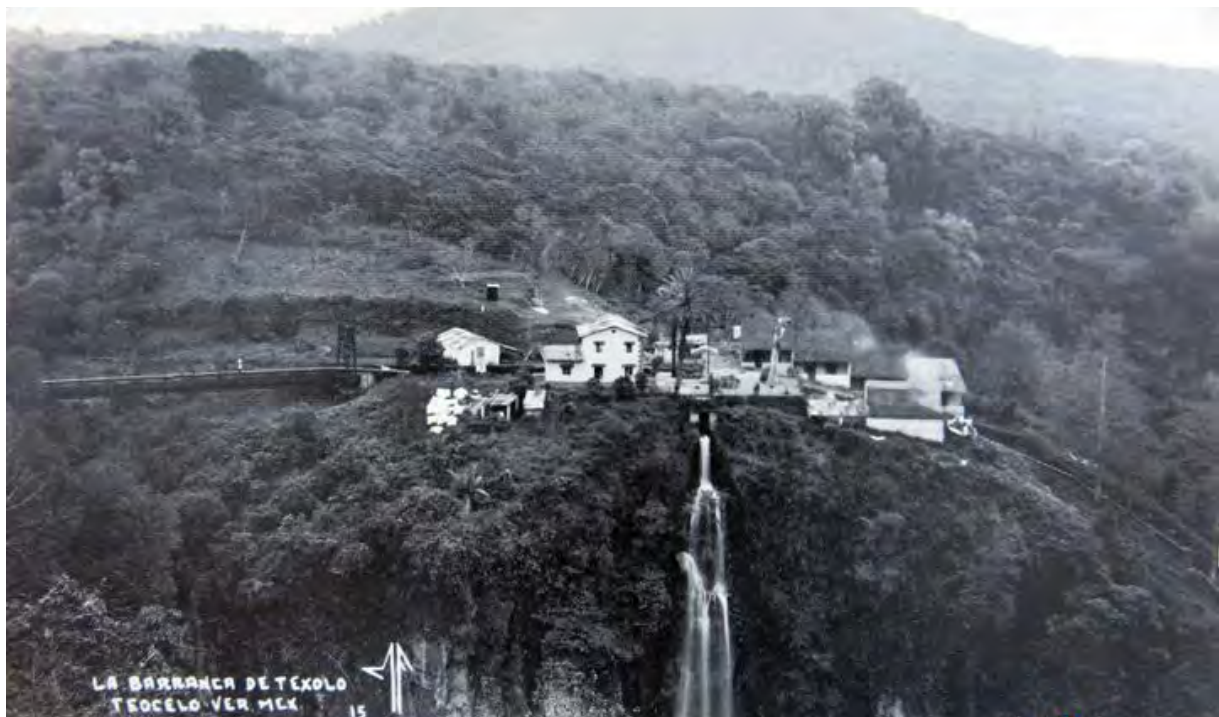
Vista panorámica histórica de la hidroeléctrica de Texolo. s/f. Tomada de "México en fotos". https://www.mexicoenfotos.com/antiguas/veracruz/teocelo/la-barranca-de-texolo-MX14430175291387
