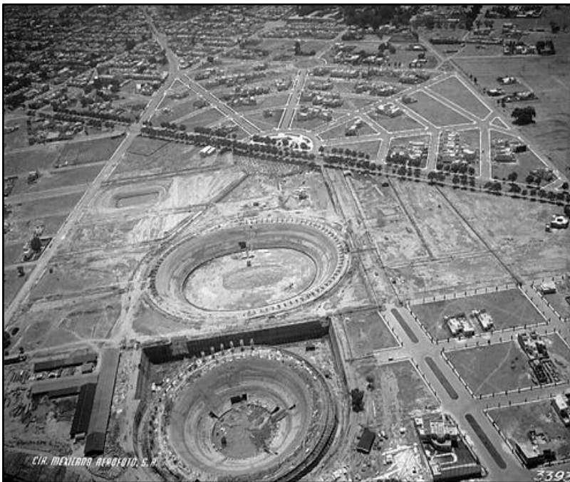
Imagen 9 Construcción de la Plaza de Toros México
