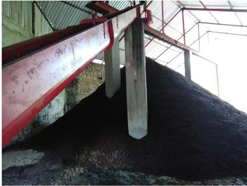
Figura 33. Bodega donde se almacena la pulpa en la Finca Nuevo México.
