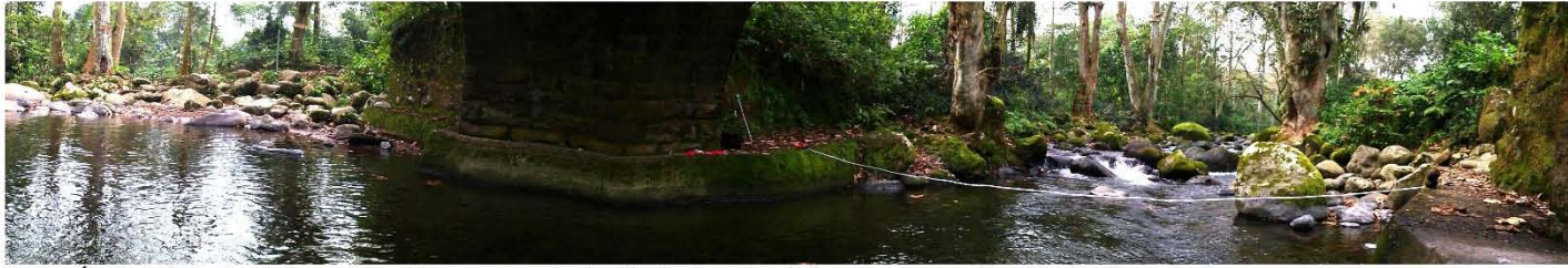
Panorámica debajo del puente, de aguas abajo (lado izquierdo) a aguas arriba (lado derecho). Fotografía de Alitzel Guzmán (Enero 2016).
