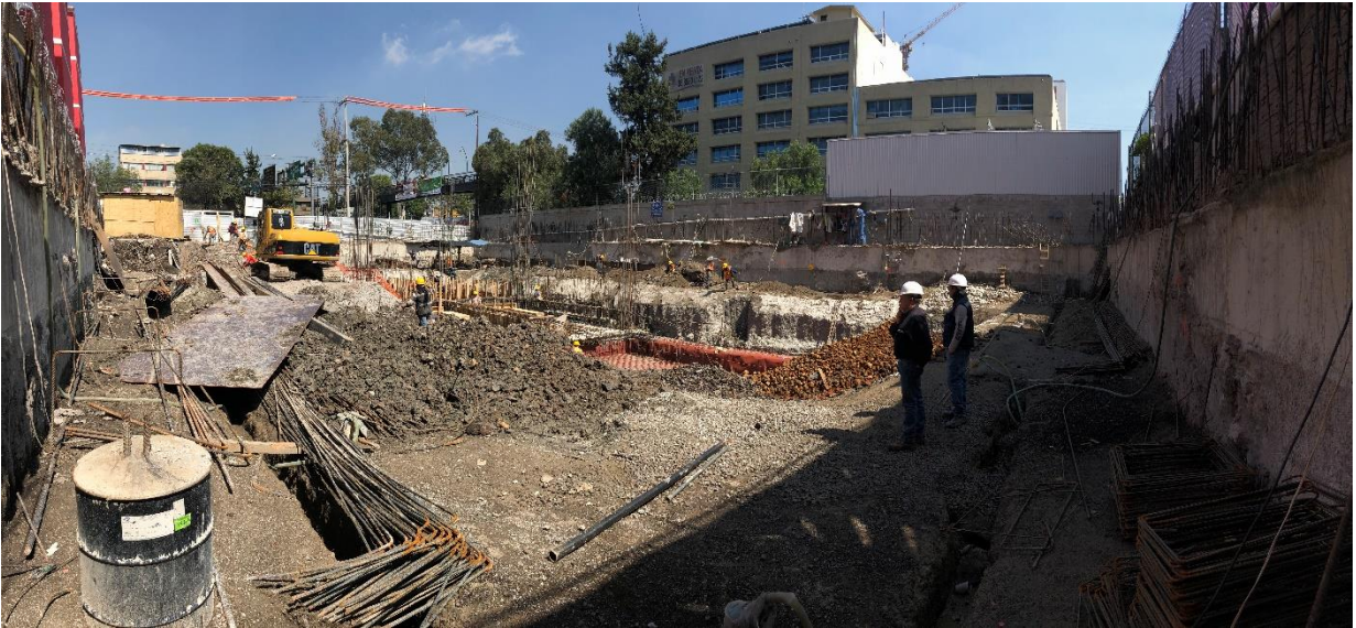
Figura 35. Vista panorámica de la excavación desde el interior del predio
