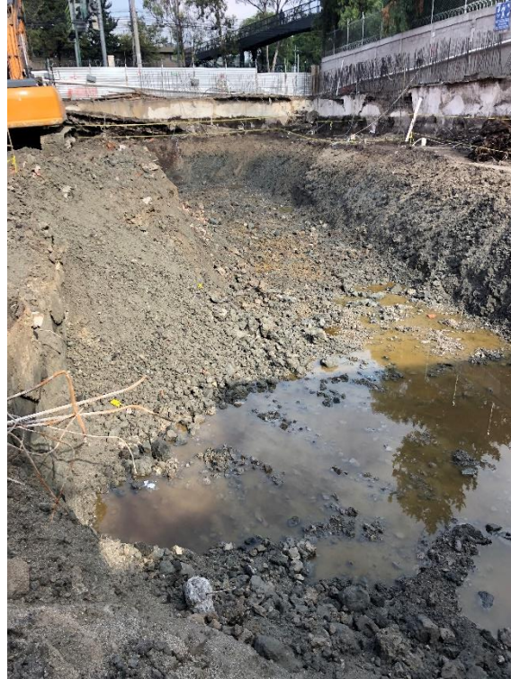
Figura 39. NAF en la excavación
