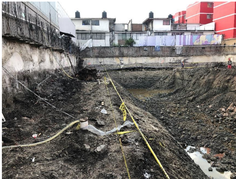
Figura 36. Excavación y bermas
