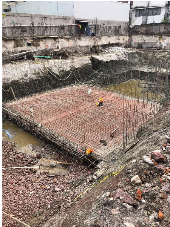
Figura 37. Construcción de la losa por etapas
