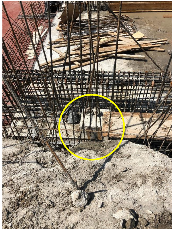
Figura 38. Preparación en losa para colocación de troqueles
