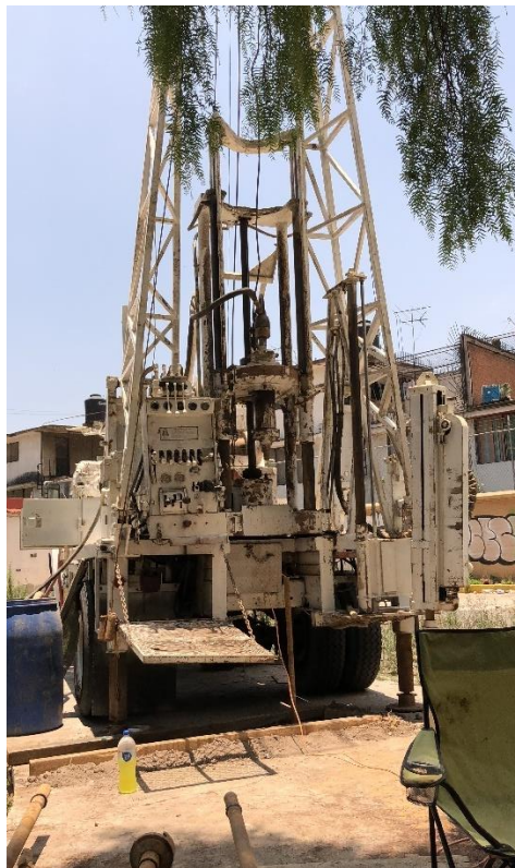
Trabajos de exploración geotécnica SE-1
