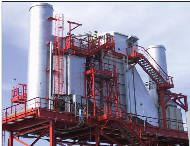
Figura 3.4.3-4 Estación de Compresión Keyspan Energy, Boiler para recuperación de calor. Fuente: Gas Liquids Engineering
