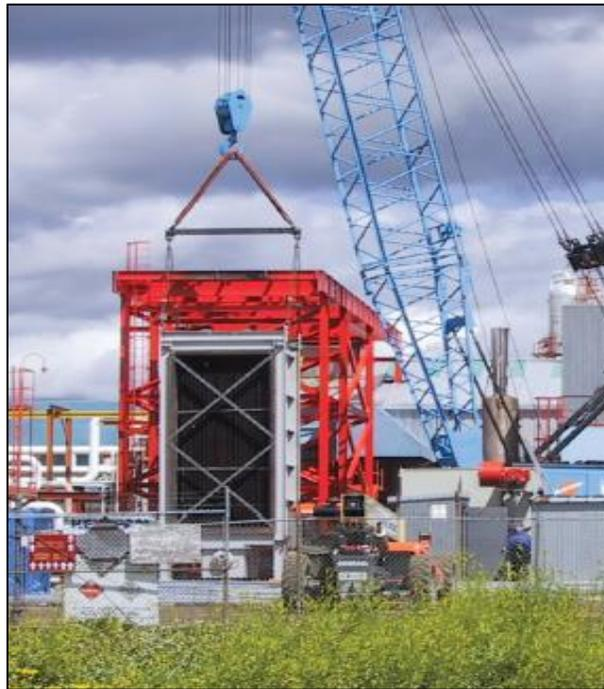
Figura 3.4.3-3 Instalación de estructura para soporte de equipo para recuperación de calor. Fuente: Gas Liquids Engineering
