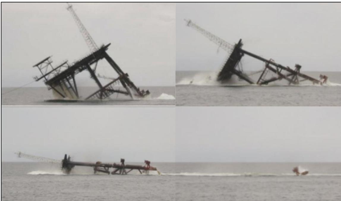
*Figura 1.2.8-2 Secuencia fotográfica del derribo en sitio de una plataforma en su sitio, el hundimiento controlado duró 37 segundos desde el primer movimiento hasta el hundimiento completo. Fuente: Oilfield Review (2002)*
