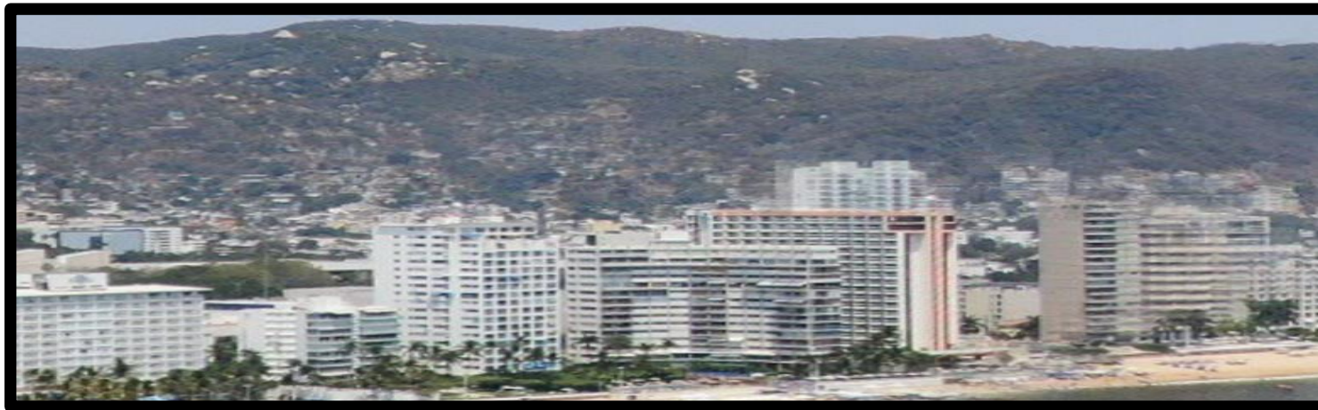
Imagen. - EL CERRO DEL VELADERO (borde) para evitar el crecimiento de la mancha urbana se creó el parque el veladero como reserva ecológica ya que es una zona con grandes barrancas y suelo con inestabilidad, por derrumbes, además de que sería muy difícil de dotar los servicios que se requieren.
