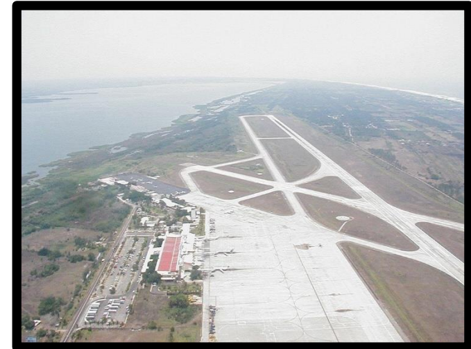
Imagen. - Pista de aterrizaje del Aeropuerto Internacional de Acapulco, por su ubicación fuera del puerto se tiene programado su crecimiento a largo plazo.
