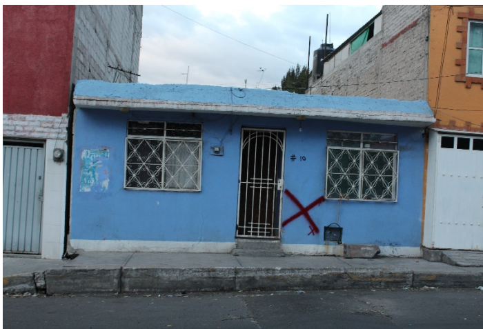
Casa dictaminada pérdida total tras sismo. – Foto propia
