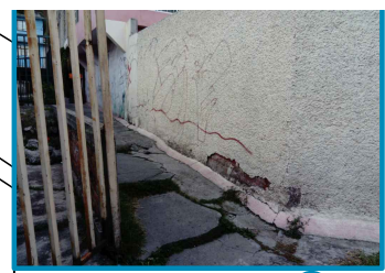
DAÑO EN MURO PERIMETRAL ②
