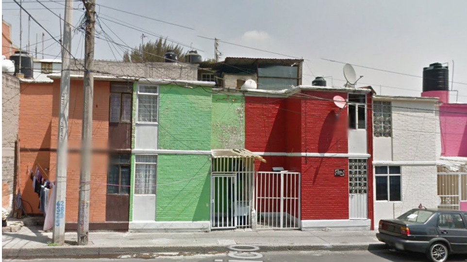
Casa dúplex– Foto propia
