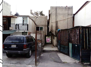
CONSTRUCCION SOBRE ANDADORES ④
