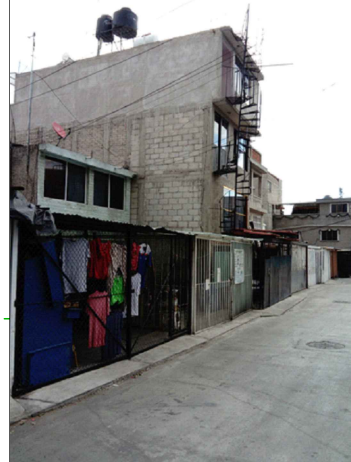
COLOCACIÓN DE JAULAS ⑥
