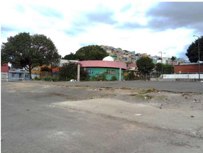
Hundimiento de la zona debido a la licuefacción de la tierra. – Foto propia
