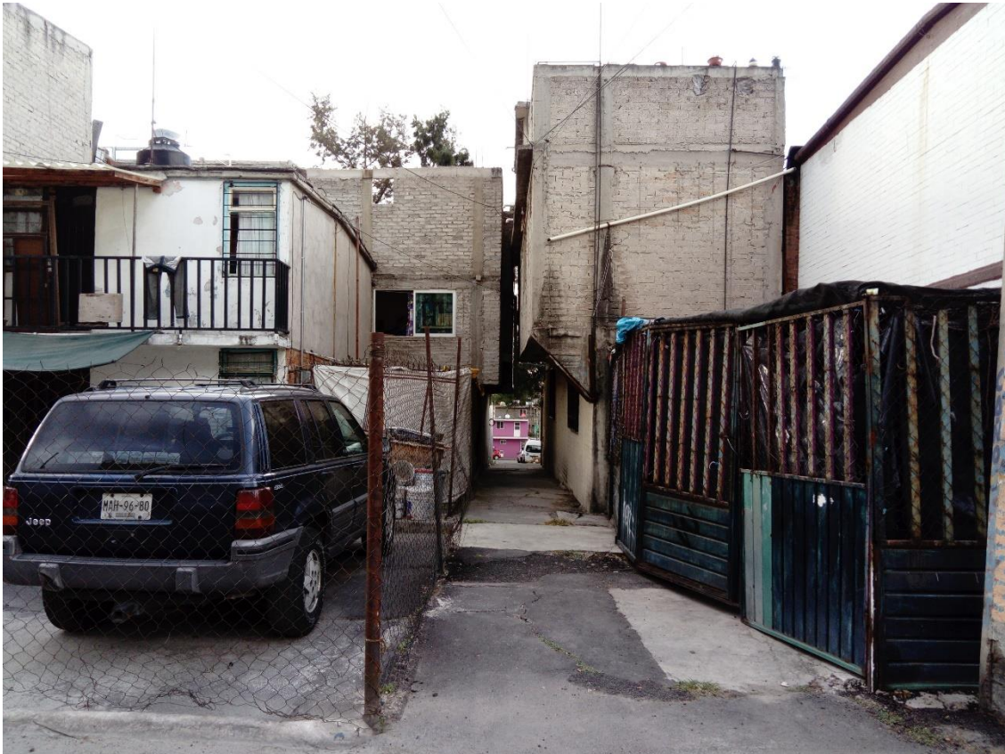
Construcción sobre andador – Foto propia
