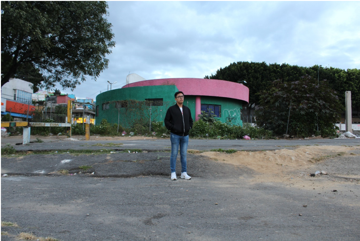
Comparación de hundimiento del suelo, la diferencia aproximada es de 60cm - Foto propia
