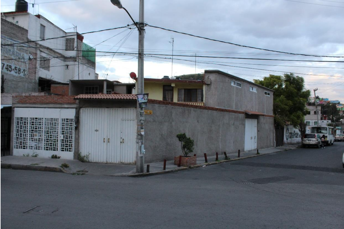
Ampliación y construcción en áreas verdes – Foto propia
