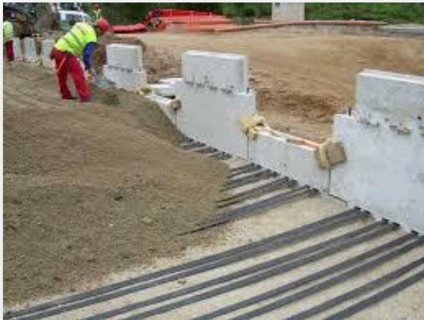
Ilustración 4. Tendido de material y refuerzos en muro mecánicamente estabilizado.
