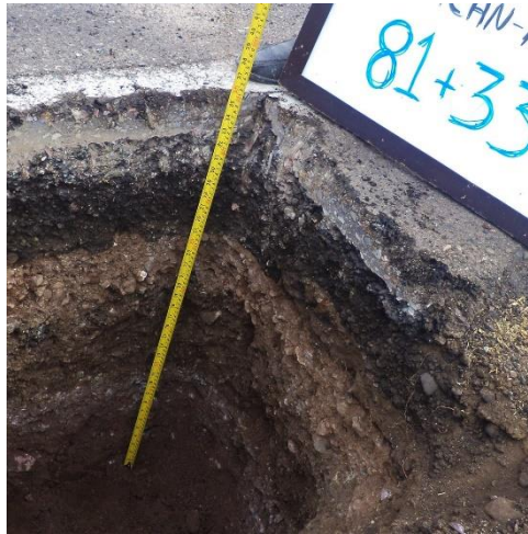
Ilustración 5. Pozo a cielo abierto.
