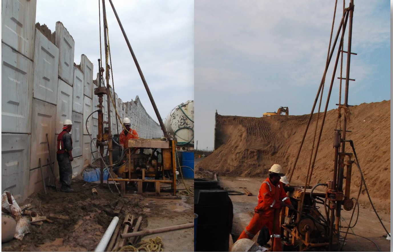
Ilustración 16. Vista de los sondeos de penetración estándar.
