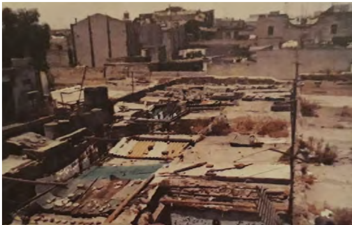
FOTO 23. Fotografía desde la azotea del fragmento del templo del Carmen, 1985 antes de la revitalización. Fotografía: Salvador Ávila.
