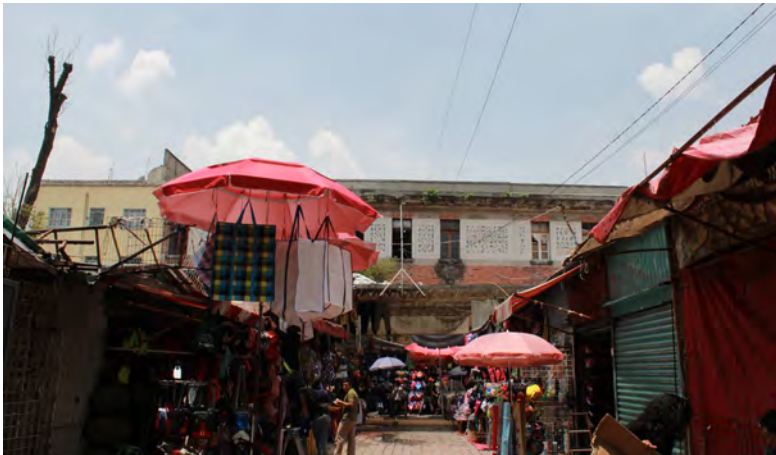
FOTO 33 Tomada desde la plaza del estudiante, sobre la cual se encuentran estas estructuras metálicas que bloquean y han convertido la plaza pública en una plaza comercial. Al fondo de la foto, podemos apreciar la casa del estudiante ocupada en la planta baja por lonas, rejillas y mesas que se cuelgan de la fachada de este inmueble declarado monumento histórico (2019)
