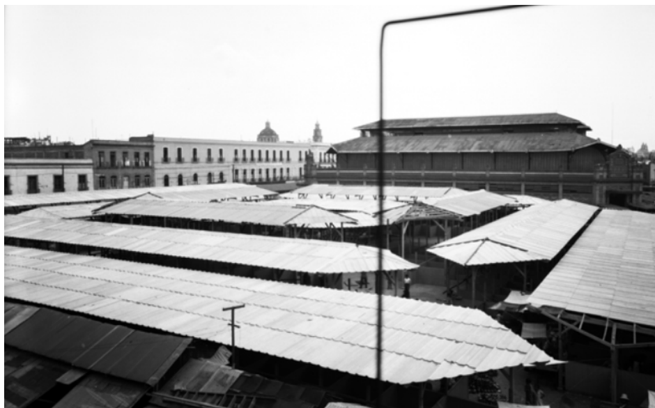
Imagen 3 Mercado de "Lagunilla", vista de los techos. Archivo Casasola, 1932. Previo a la demolición del mercado. No. Identificador oai:mexicana.cultura.gob.mx:0010000/0319711
