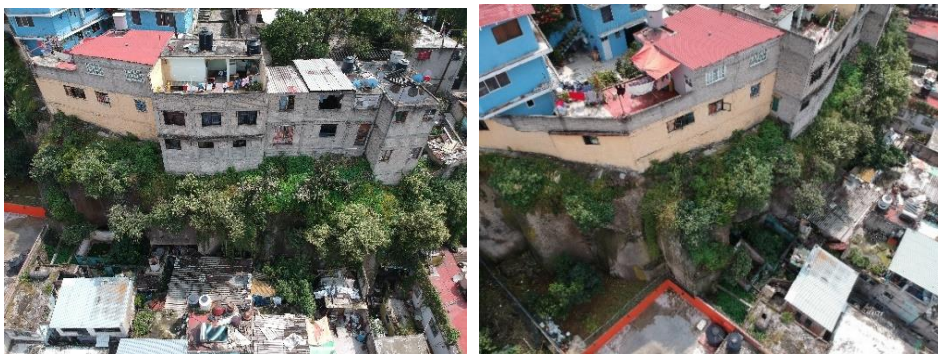
Figura. 77-78. Viviendas ubicadas en la corona de la ladera. Elaboración propia.
