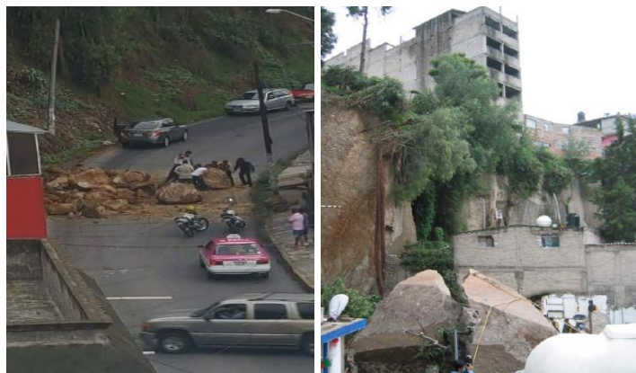
Figura 24. Caída de rocas.
