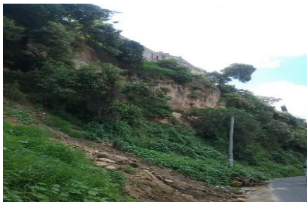
Figura 26. Deslizamiento Translacional. Elaboración propia.
