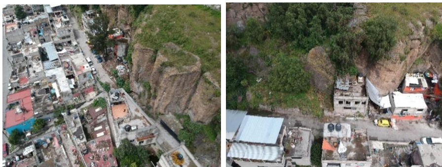
Figuras. 69-70. Construcciones de muros de mampostería y losas de concreto reforzado. Elaboración propia.
