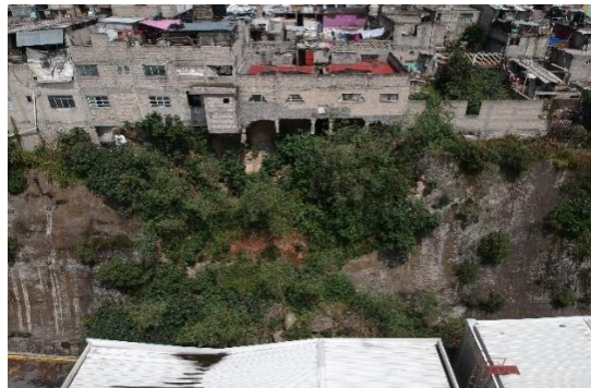
Figura 22. Deslizamiento, en calle San Isidro en la colonia granjas
