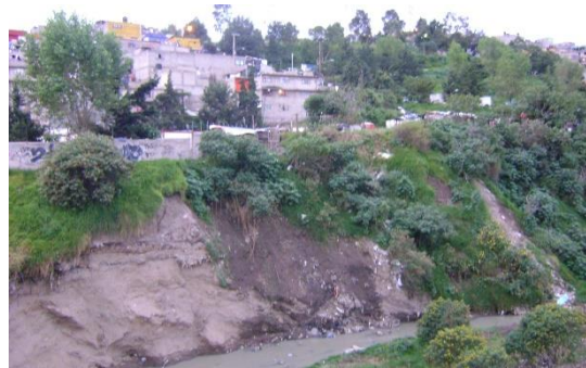
Figura 25. Deslizamiento Rotacional. Elaboración propia.
