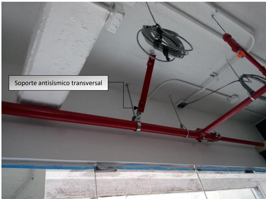
Figura 28. Soportería antisísmica instalada. Fotografía tomada en sitio.
