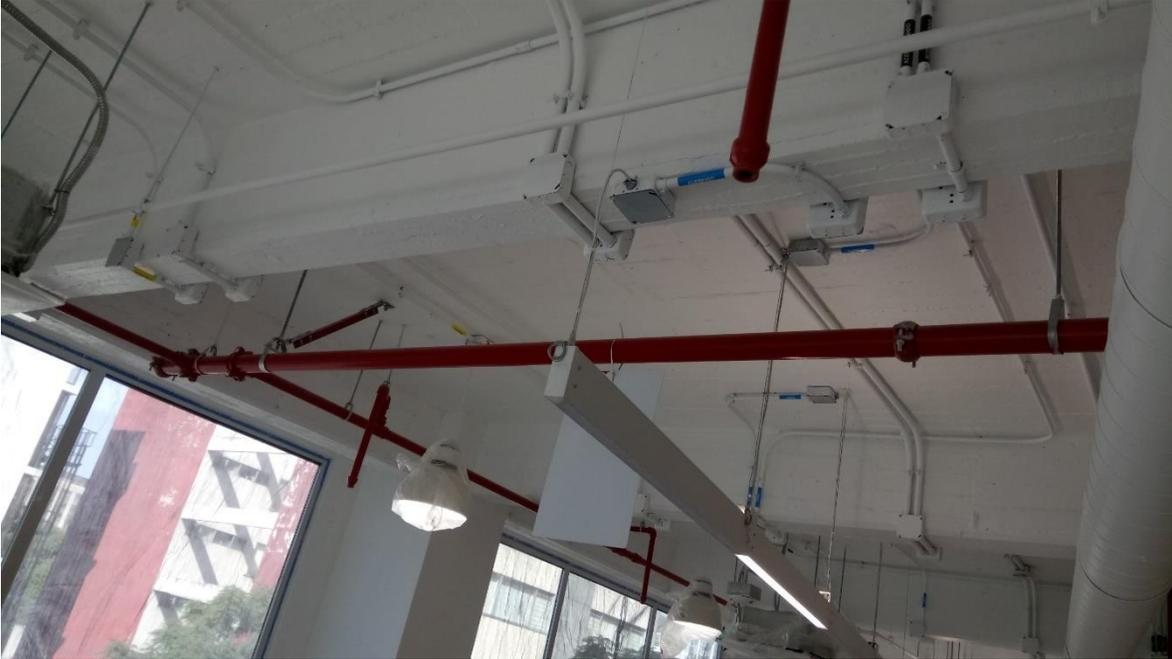
Figura 29. Colgantes y soportería antisísmica instalados. Fotografía tomada en sitio.
