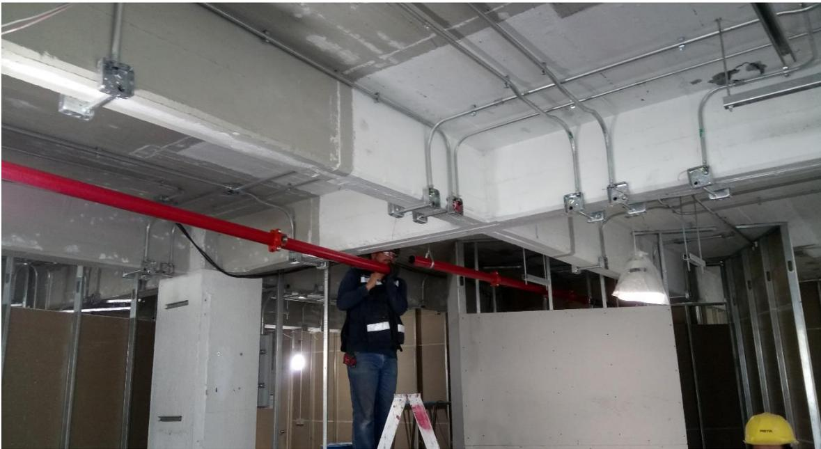
Figura 15. Ensamblado de cabezal. Fotografía tomada en sitio.
