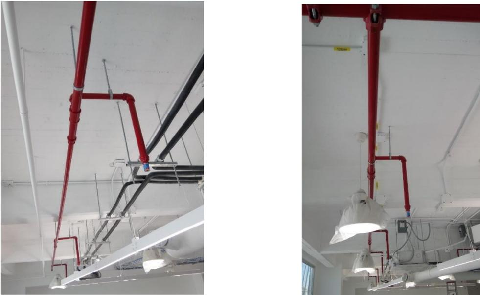
Figura 21. Ramales instalados listos para prueba. Fotografías tomadas en sitio.
