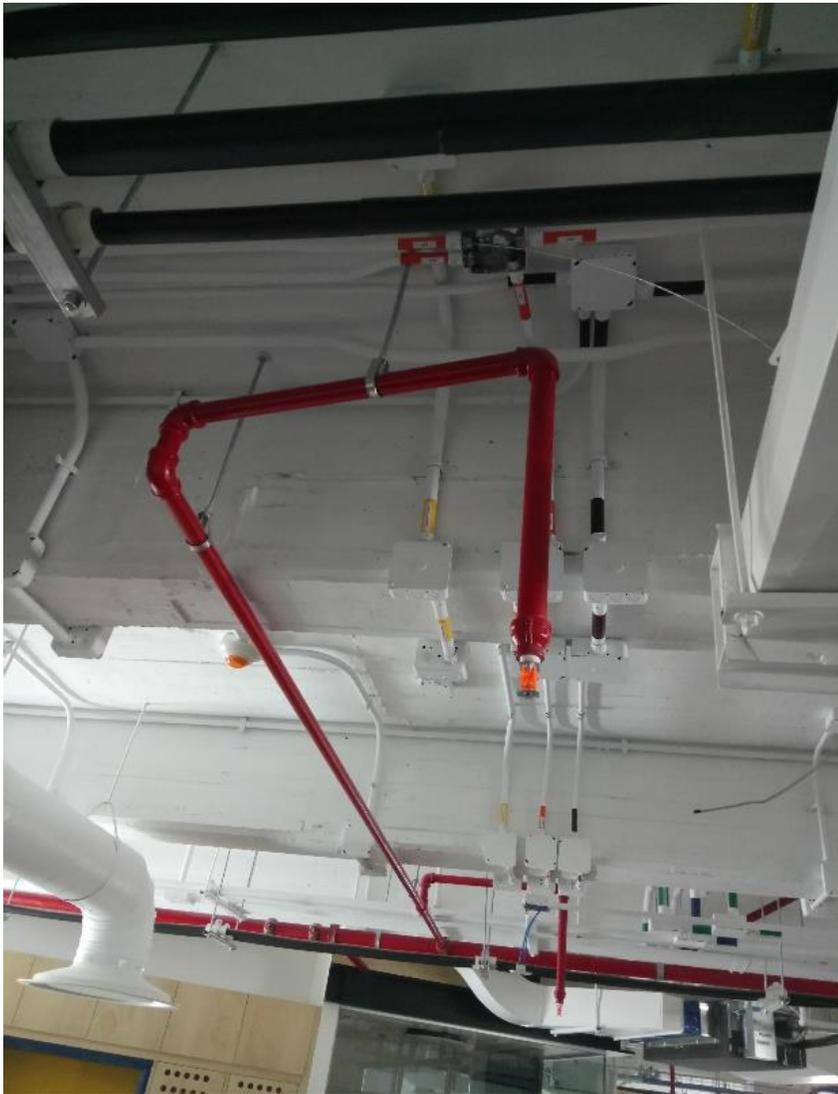
*Figura 37. Soportería en ramal. Fotografía tomada en sitio.*
