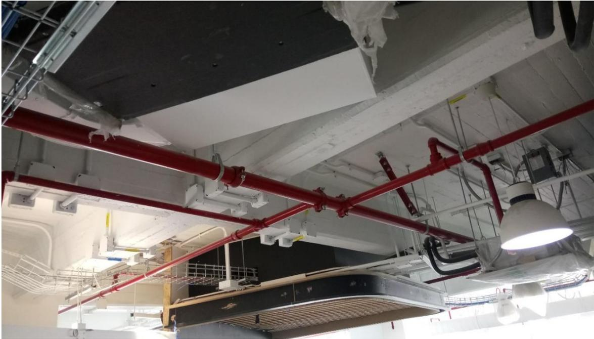
Figura 18. Cabezal o troncal instalado en nivel 3. Fotografía tomada en sitio.
