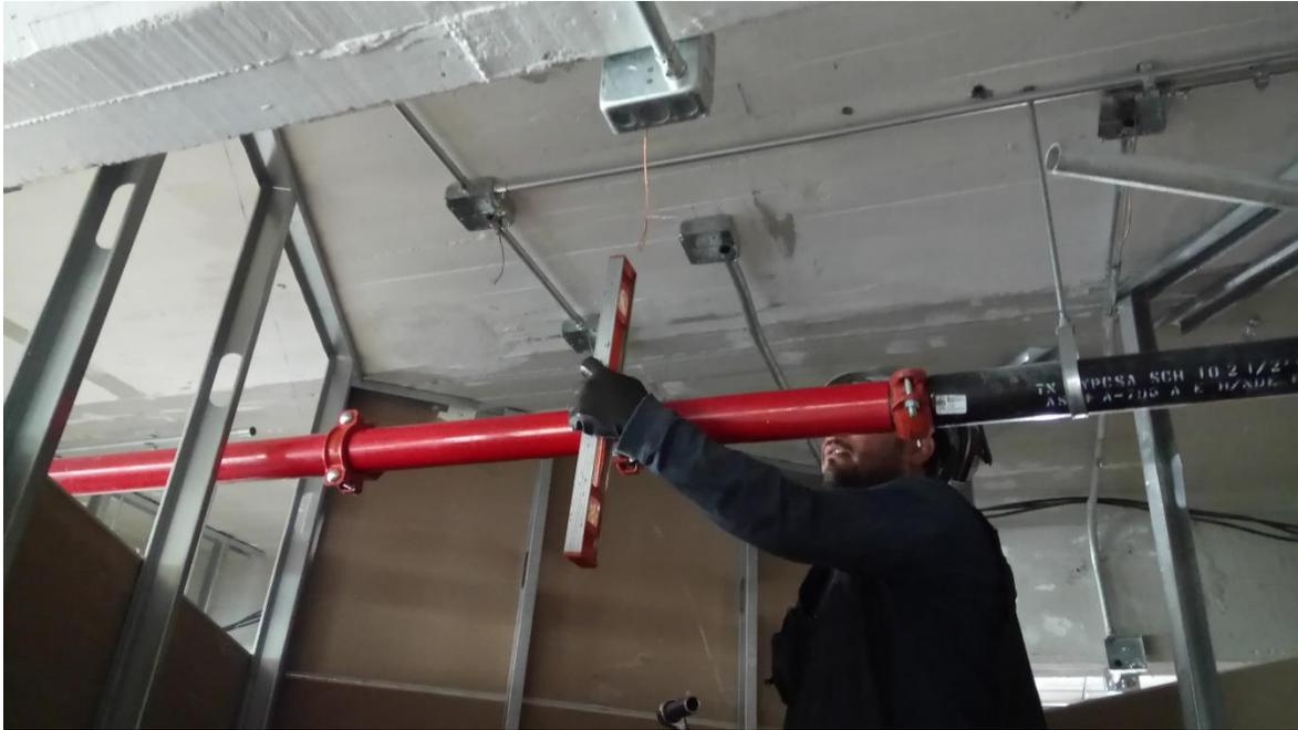
Figura 14. Nivelación de salidas de ramales en el troncal. Fotografía tomada en sitio.
