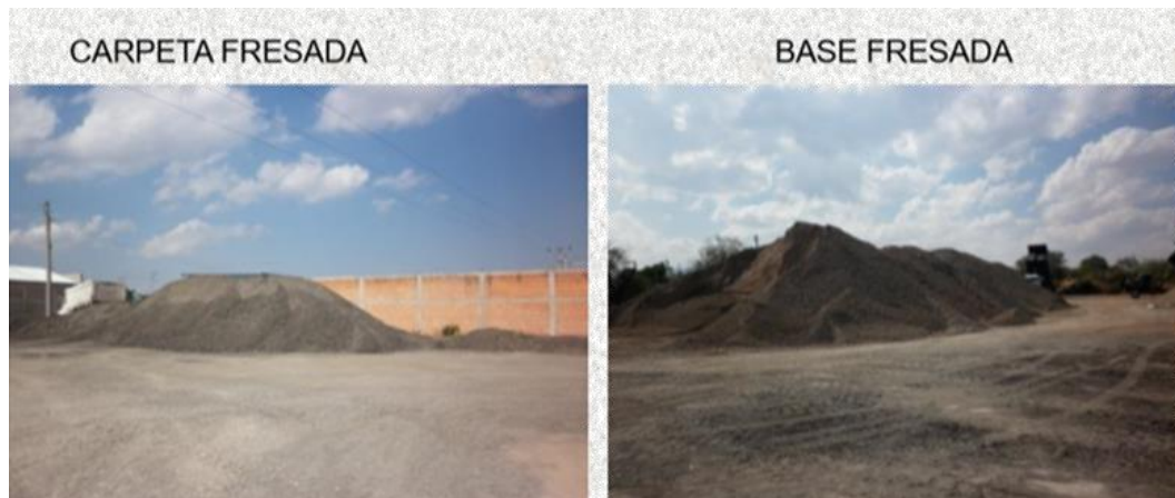
Ilustración 30 Almacenamiento del material fresado.
