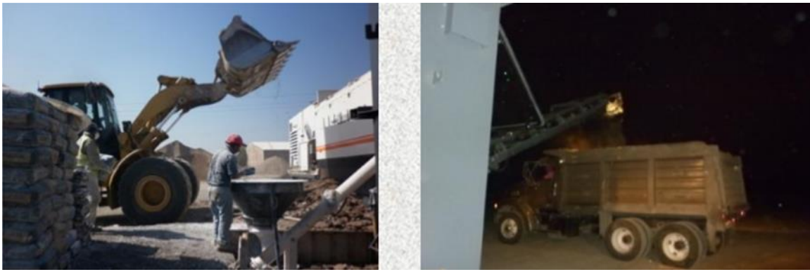
Ilustración 32 Elaboración del asfalto espumado.
