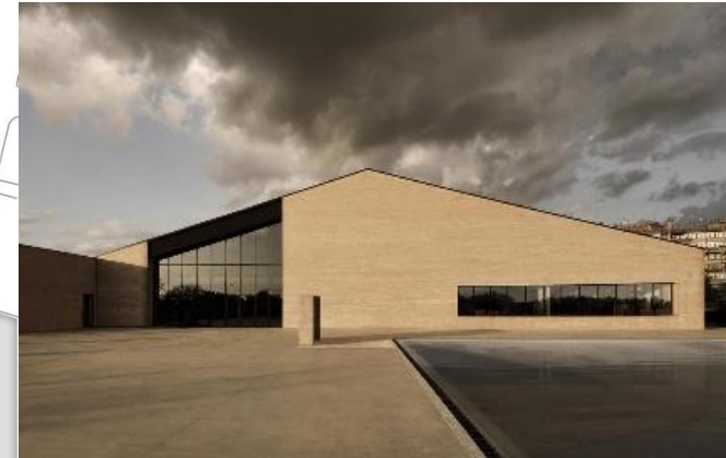
Fotografía 9. Fachada Norte. Villa Deportiva Supreme. Fuente: ArchDaily.
