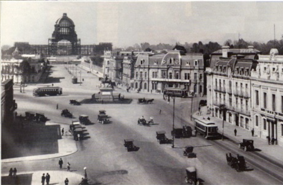
Palacio Legislativo en construcción. Visto desde el cruce de Av. Juárez y Paseo de la Reforma, 1910. Tomada del libro El sueño inconcluso de Emile Bernard y su palacio legislativo, México 2010
