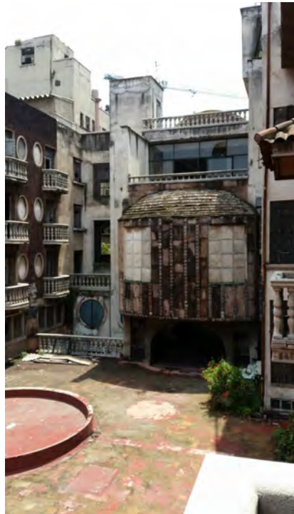
FOTO 12.A: Espejo de agua en el "Patio Guadalajara", visto desde la terraza del edificio G.
