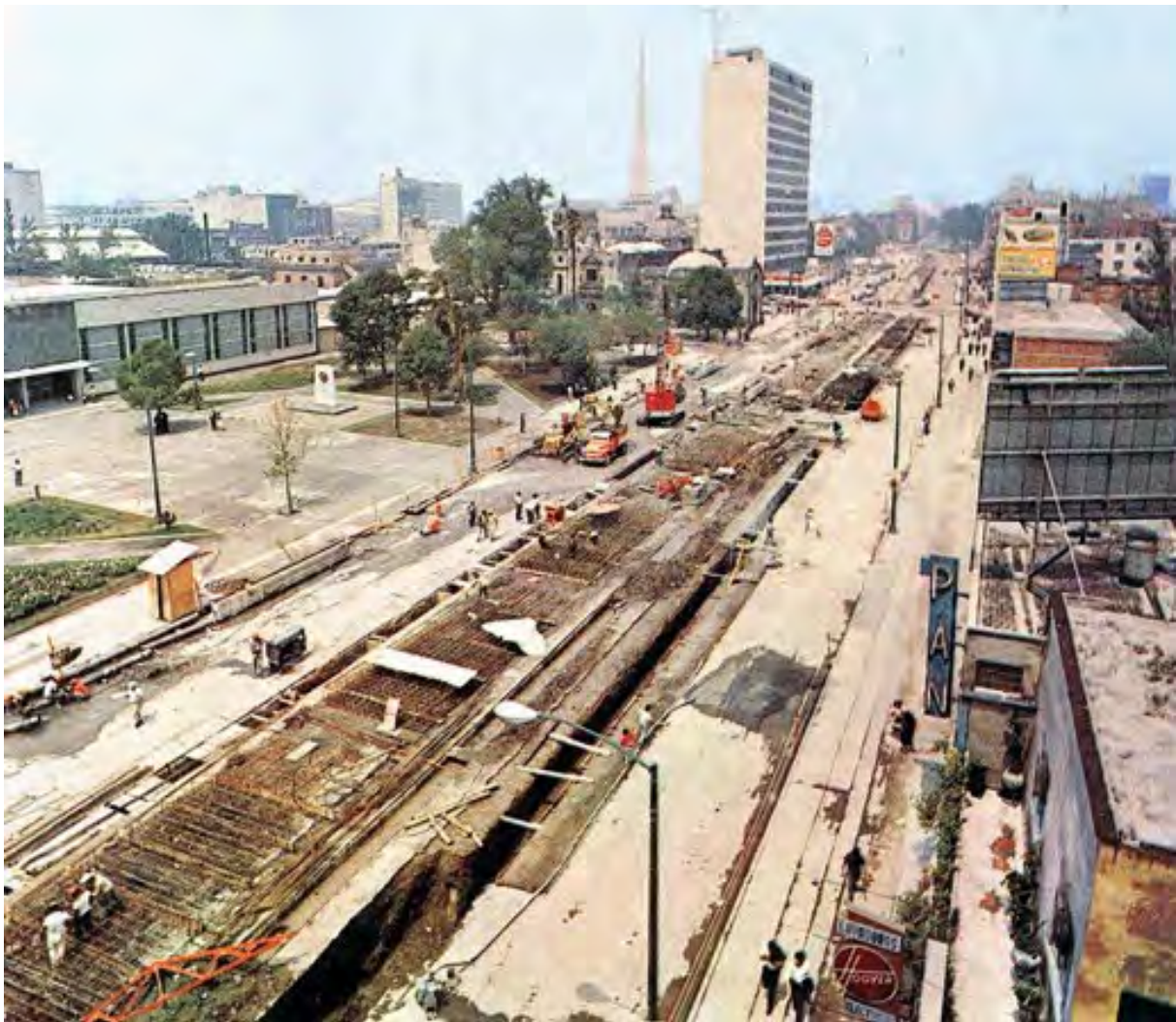
Fotografía de 1968 de la construcción de la línea 1 del Metro sobre la Av. Arcos de Belén. A la izquierda pueden observarse las oficinas del Registro Civil, el templo de Belén de los Mercedarios, "las Merceditas", y las antenas del Televisión. La panadería al lado derecho aún existe.
