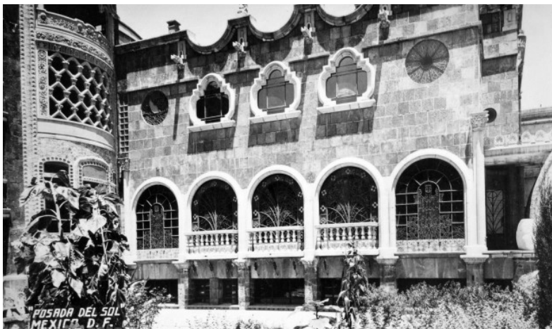
Fachada del edificio F
