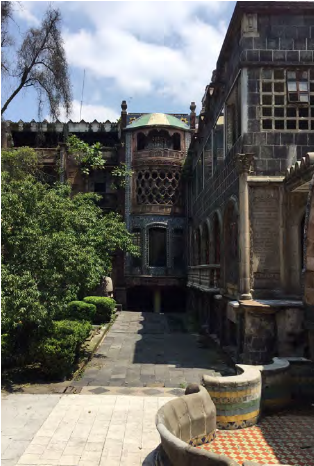
FOTO 18: Fachada del núcleo de escaleras del edificio G, vista desde la fuente del jardín principal.
