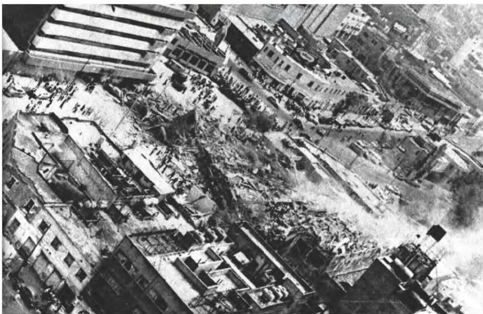
FOTO 1: Derrumbe tras el terremoto de 1985 sobre Av. Arcos de Belén y Dr. Vertiz.
