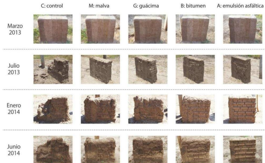
Ilustración 3.17. Monitoreo de adobes experimentales de prueba. C: sin estabilizante, m: extracto de malva, g: extracto de guácima, b: bitumen, a: emulsión asfáltica (Kita et al., 2014)
