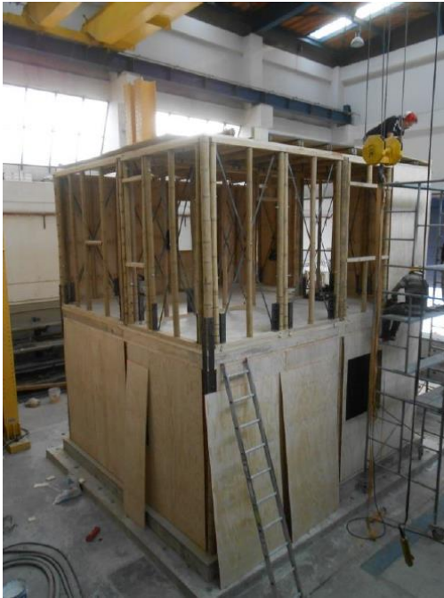
Figura 4.1.4 Fotografía donde se muestra el proceso de construcción de la casa.
