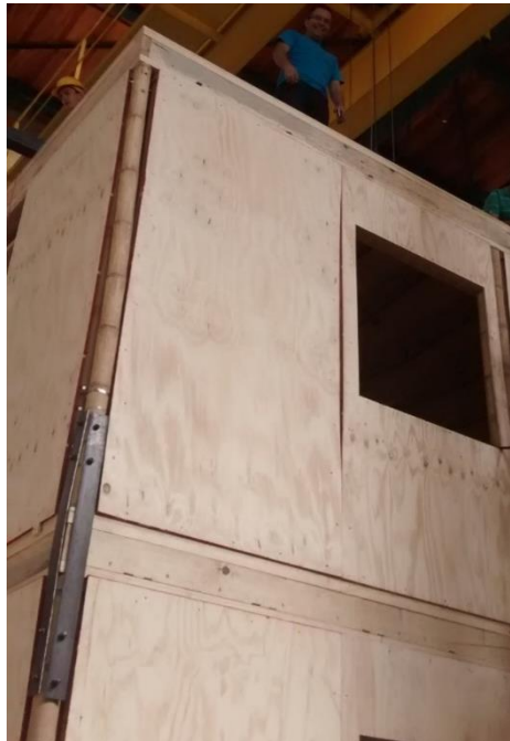
Figura 4.1.6 Fotografía que muestra una columna exterior de la casa
