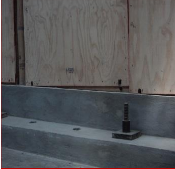
Figura 6.1 Fotografía que muestra el desplazamiento de paneles en la planta baja tras las pruebas de esfuerzo.
