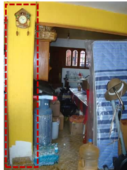
Columna anexada posteriormente sin ningún agrietamiento.
