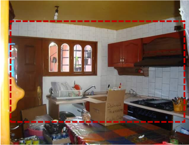
Cocina – Sin acceso por acumulación de cosas, pero sin daño estructural.
