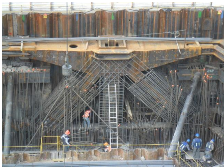
Figura 4.5. Construcción de la trabe de coronamiento perimetral de la estructura. (CIMESA - Soletanche-Bachy, 2012)
