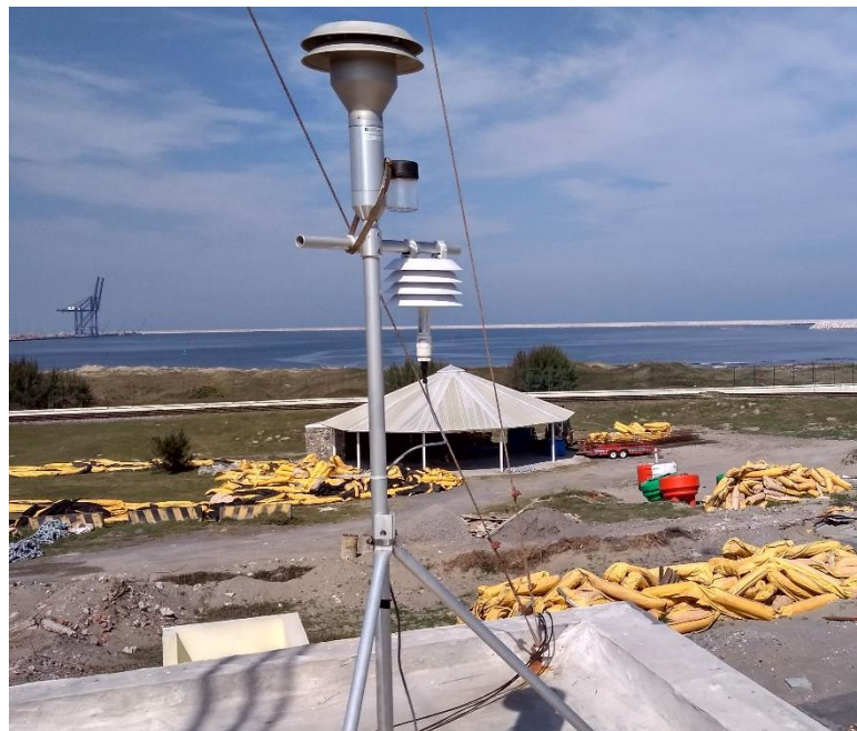
Figura 18. Cabezal del equipo analizador de PM 10 BAM1020.
