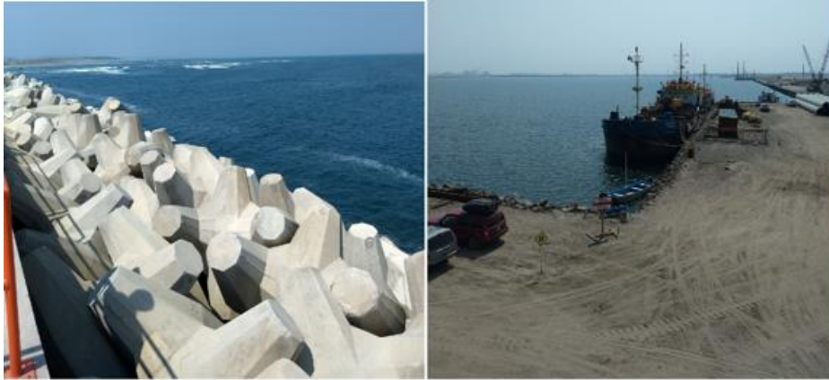
Figura 12. Construcción del nuevo puerto de Veracruz.
