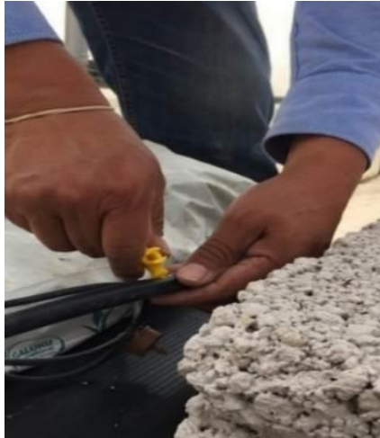
Figura 20: Perforación de la cintilla de riego
